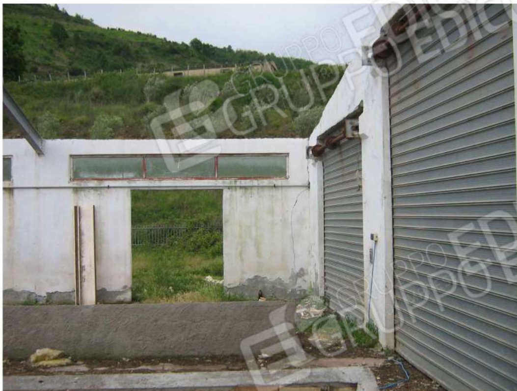
Foto n. 93: particolare ingressi lato Ovest-Sud-Ovest - Fabbricato "E" (lotto n. 4).
