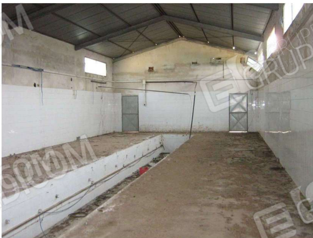
Foto n. 142: ambiente mungitura - fabbricato "H" (lotto n. 3).
