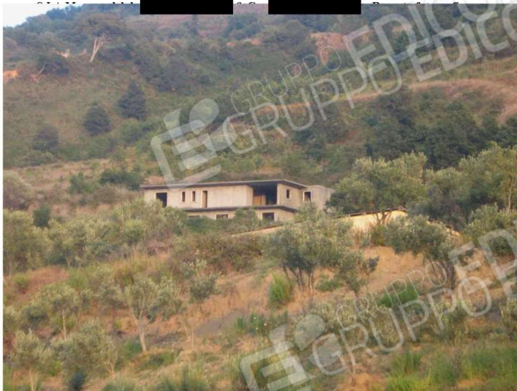
Foto n. 13: foto prospettica del fabbricato "A" (lotto n. 4).
