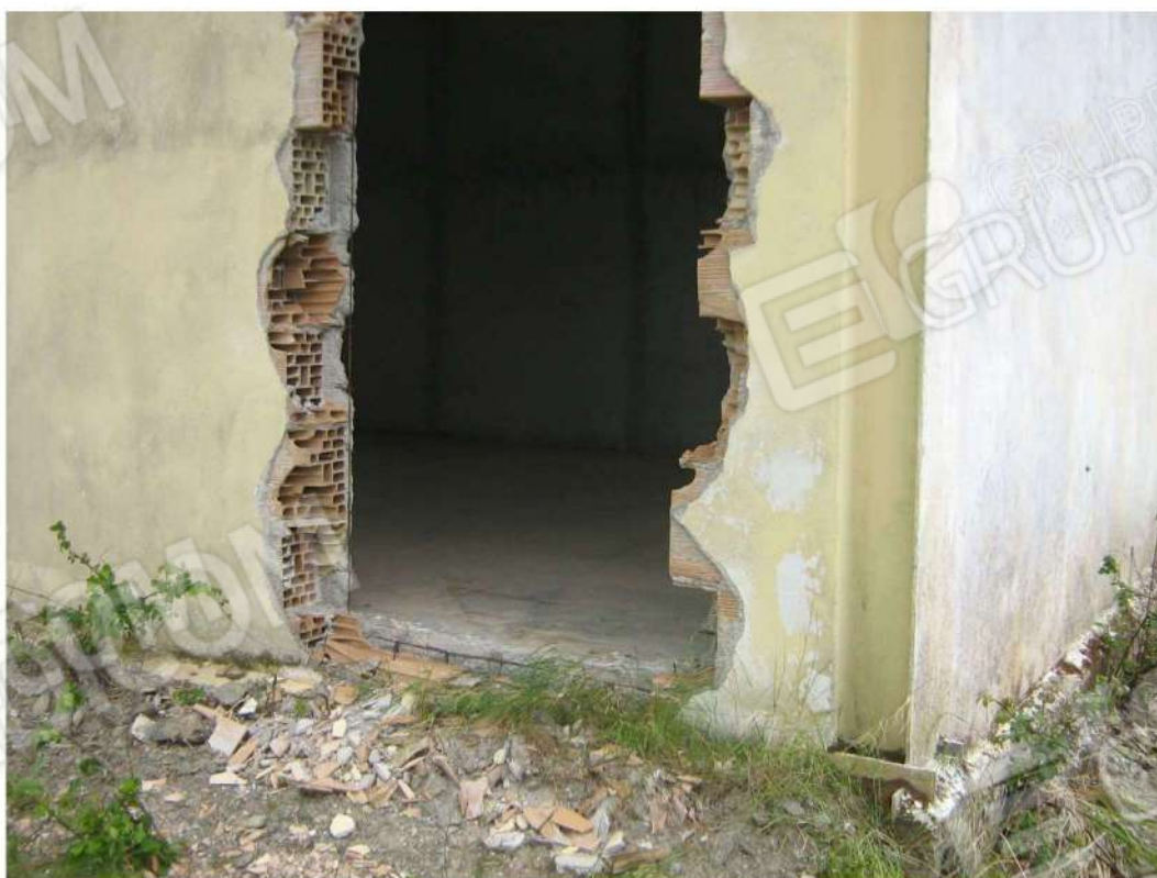
Foto n. 112: particolare ingresso prospetto Nord-Nord-Ovest - Fabbricato "F" (lotto n. 3).
