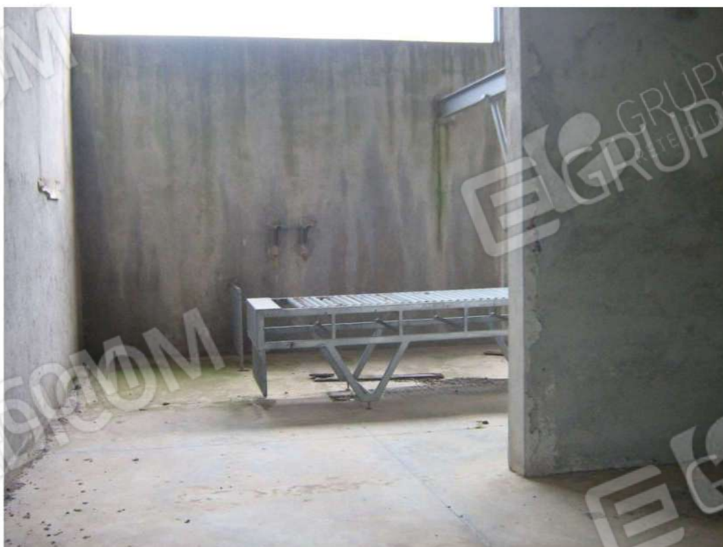
Foto n. 108: particolare tompagnatura - Fabbricato "F" (lotto n. 3).
