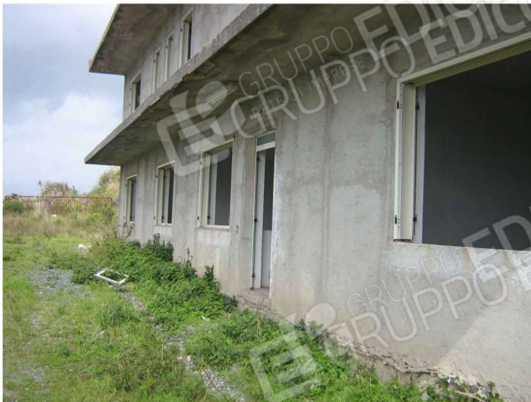
Foto n. 15: particolare fabbricato "A" (lotto n. 4).
