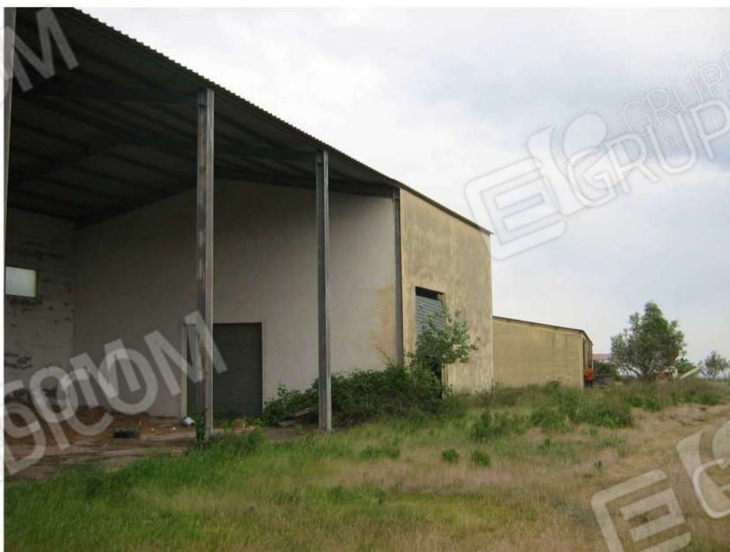
Foto n. 70: foto prospettiva corpo centrale - Fabbricato “D” (lotto n. 4).
