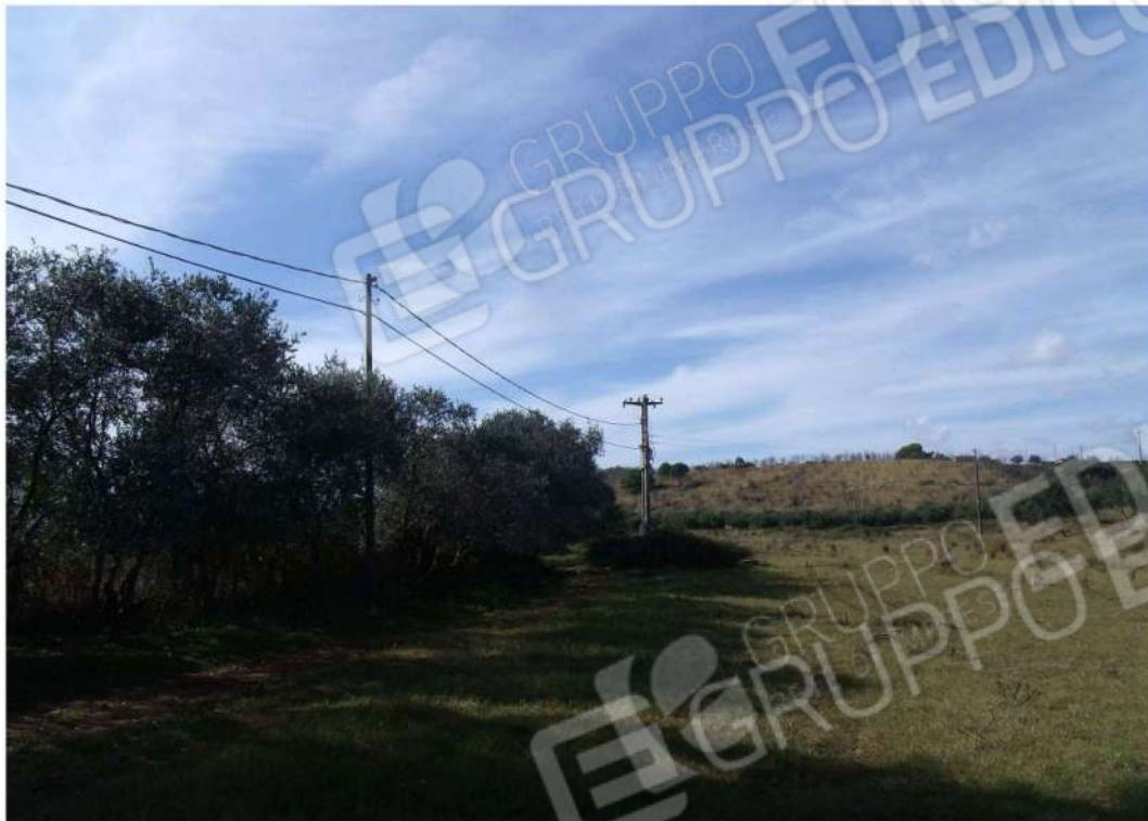
Foto n. 1: foto prospettica del lotto n. 1 ubicato nel comune di Feroletto Antico (si osservi l'elettrodotto, che attraversa la particella 155 del foglio di mappa 22 di Feroletto Antico).
