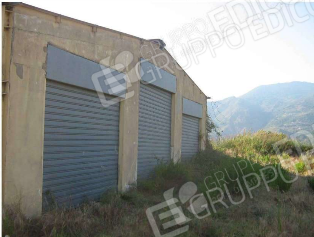
Foto n. 127: prospetto Est-Nord-Est - Fabbricato "I" (lotto n. 3).
