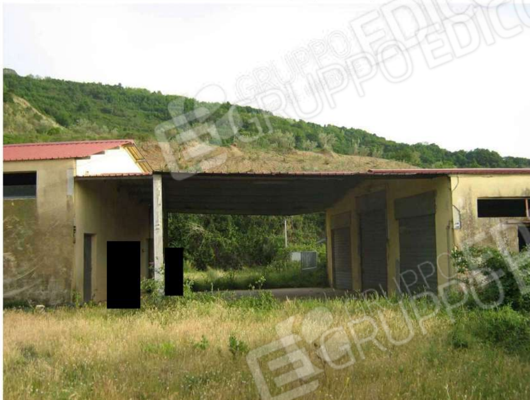
Foto n. 119: foto prospettiva tettoia posta tra i fabbricati “H” e “G”, da sinistra a destra (lotto n. 3).
