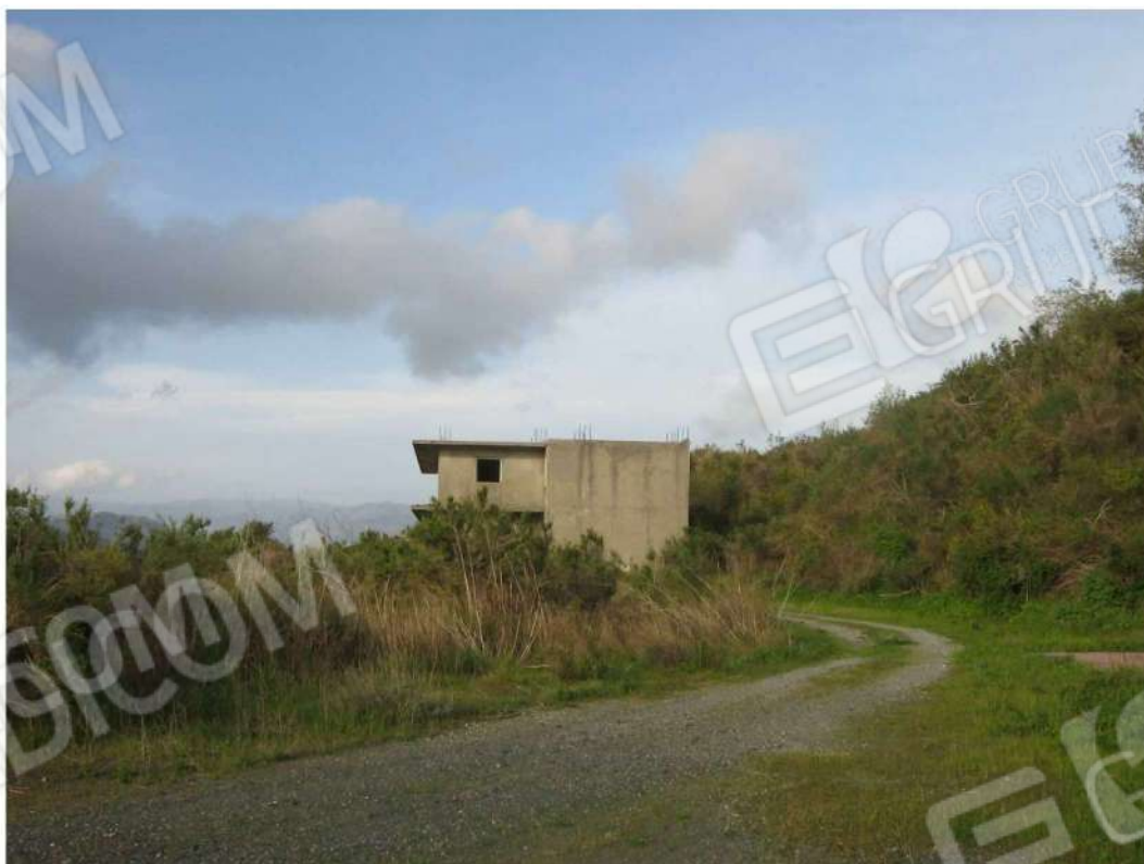
Foto n. 14: prospetto Sud-Ovest del fabbricato "A" (lotto n. 4).
