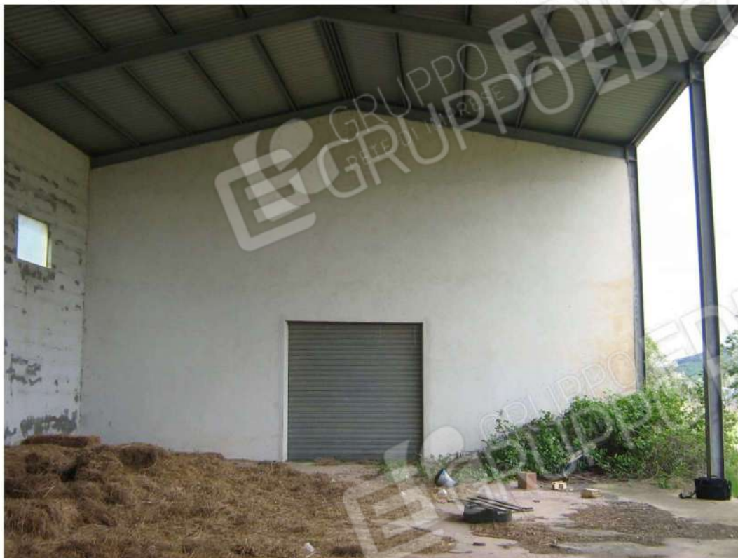
Foto n. 75: particolare ingresso del corpo lato Ovest-Sud-Ovest - Fabbricato "D" (lotto n. 4).
