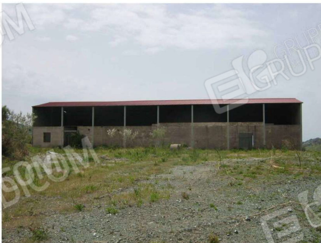
Foto n. 102: prospetto Est-Nord-Est - Fabbricato "F" (lotto n. 3).
