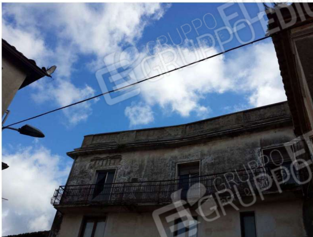
Foto n. 147: Prospetto Ovest fabbricato ubicato sul corso Garibaldi del comune di Maida (lotto n. 6).
