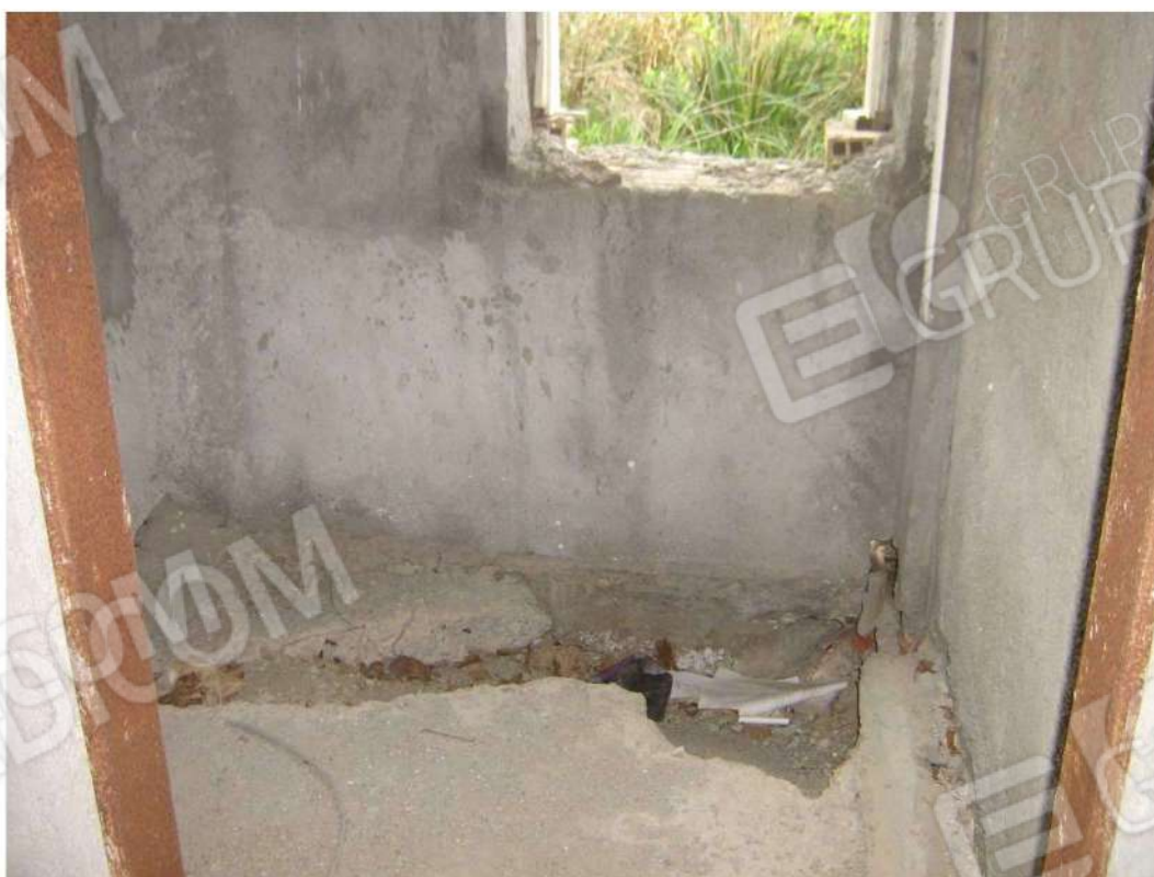
Foto n. 30: particolare traccia necessaria alla realizzazione dell'impianto di scarico - Fabbricato "A" (lotto n. 4).
