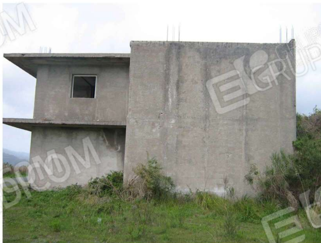
Foto n. 16: prospetto Sud-Ovest del fabbricato "A" (lotto n. 4).
