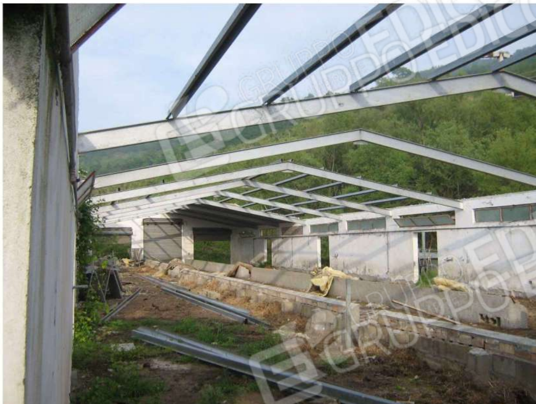
Foto n. 83: particolare struttura di copertura; foto scattata in data 2 maggio 2008 , dalla quale si evince la presenza di arcarecci (profilati in acciaio di sezione del tipo “omega”) costituenti l’orditura secondaria portante della struttura di copertura - Fabbricato “E” (lotto n. 4).
