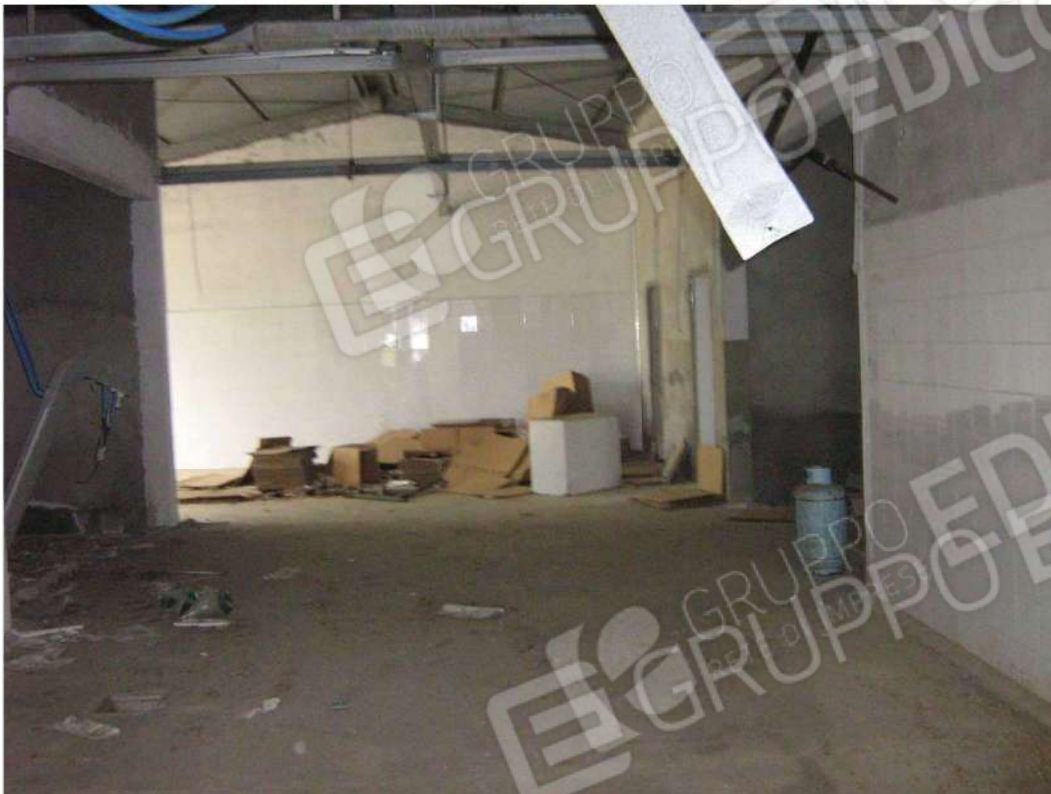
Foto n. 59: particolare ambiente interno - Fabbricato "C" (lotto n. 4).
