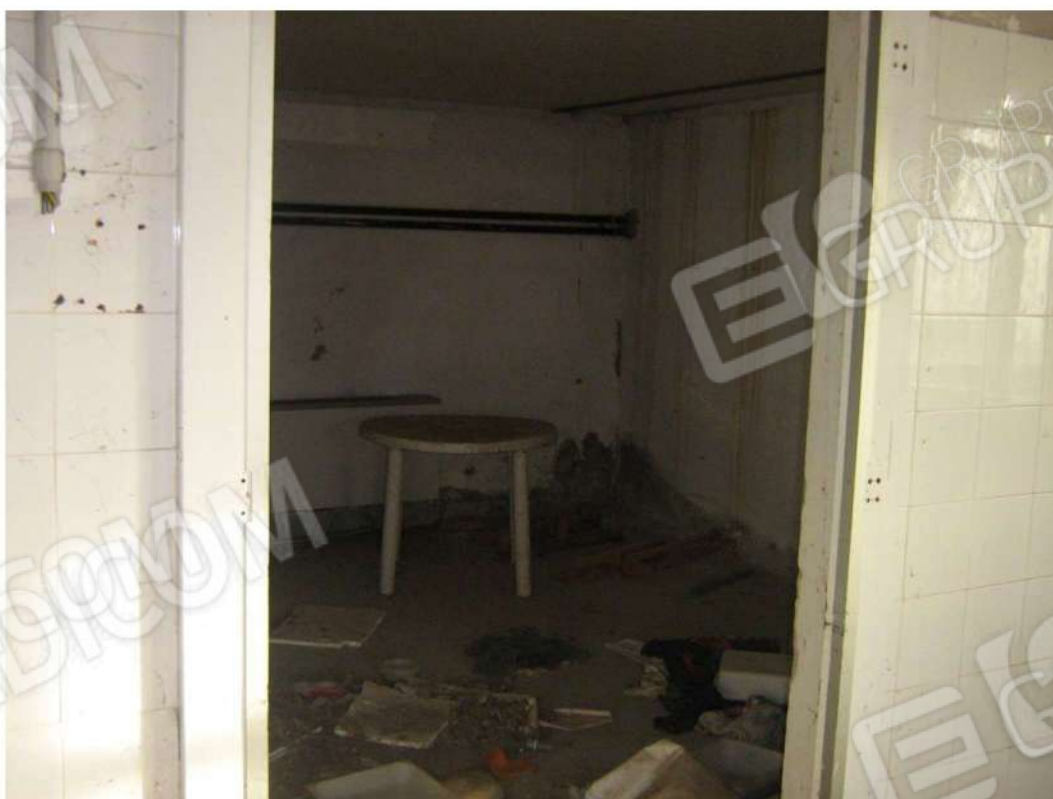
Foto n. 62: particolare vano interno - Fabbricato "C" (lotto n. 4).
