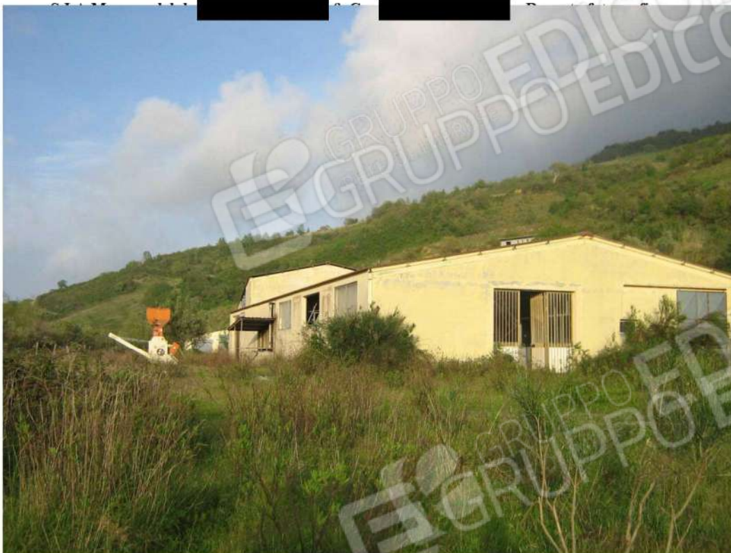
Foto n. 51: foto prospettica del fabbricato "C", già adibito a caseificio (lotto n. 4).
