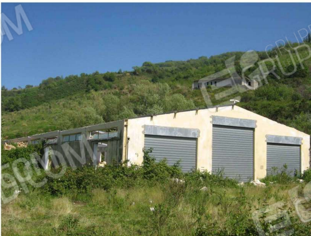
Foto n. 80: prospetti Ovest-Sud-Ovest e Nord-Nord-Ovest - Fabbricato “E” (lotto n. 4).
