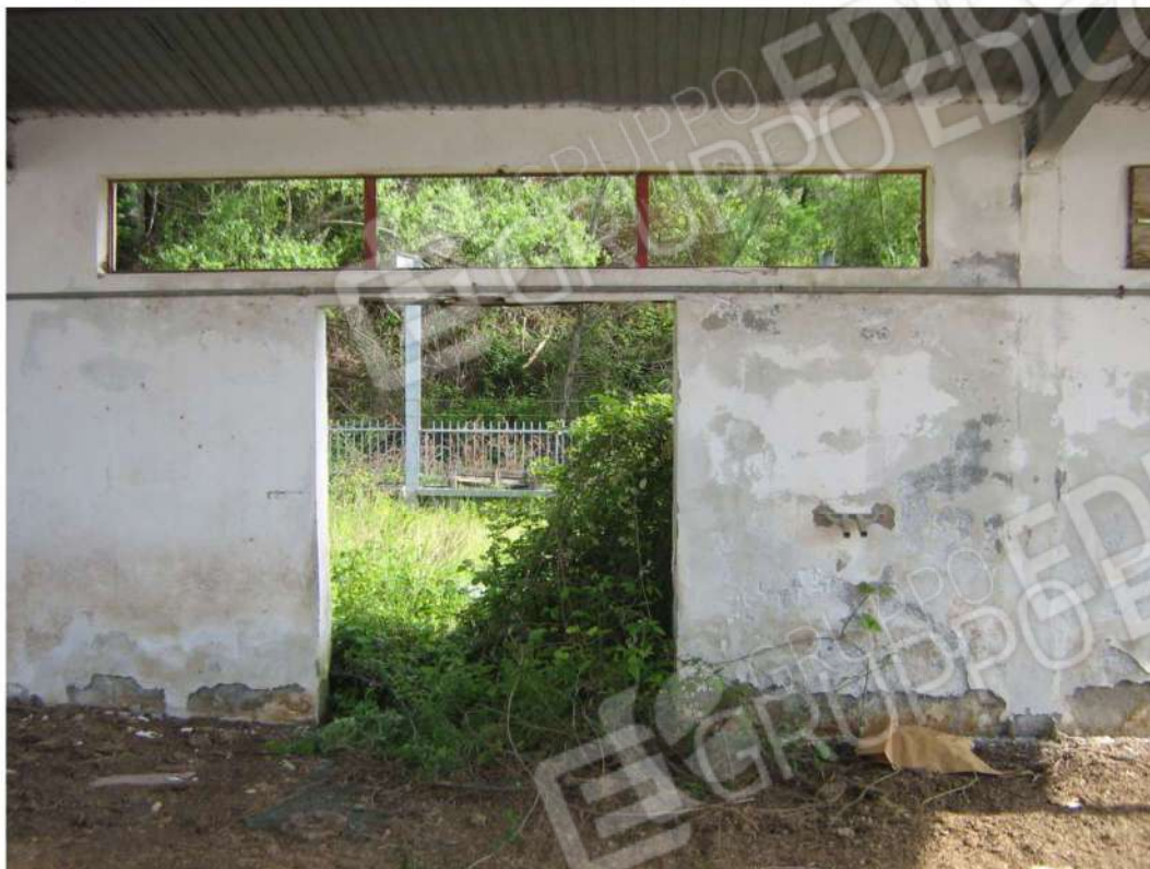
Foto n. 91: particolare ingresso lato Sud-Sud-Est - Fabbricato "E" (lotto n. 4).
