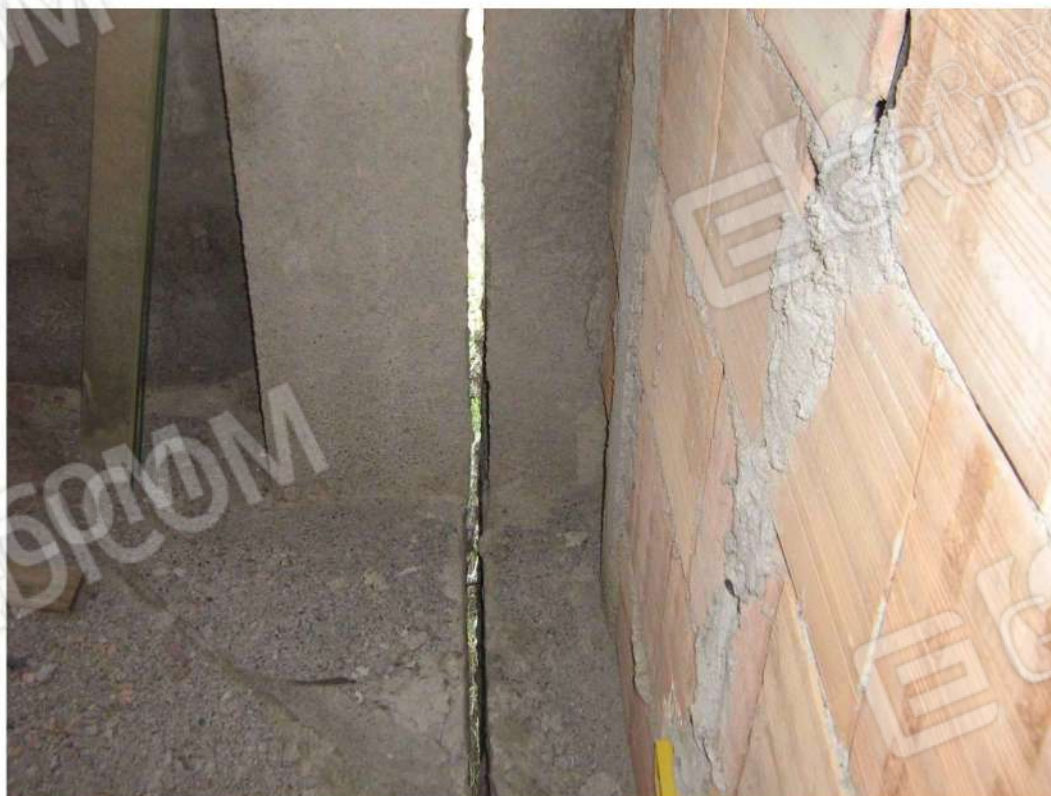
Foto n. 32: particolare giunto tecnico di cui alla fotografia n. 31 sopra riportata.
