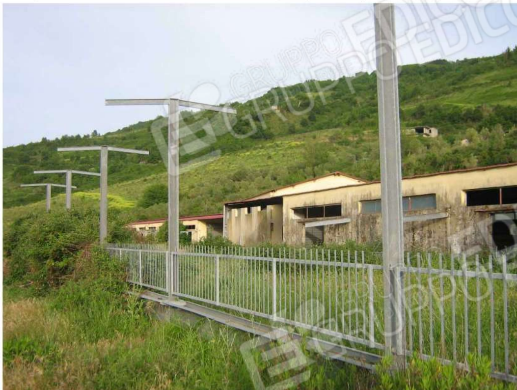
Foto n. 129: foto prospettiva fabbricati “G”-“H”-“I”, da sinistra a destra (lotto n. 3).
