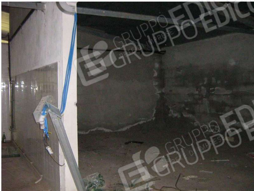
Foto n. 67: particolare vano lato Nord-Nord-Ovest - Fabbricato "C" (lotto n. 4).
