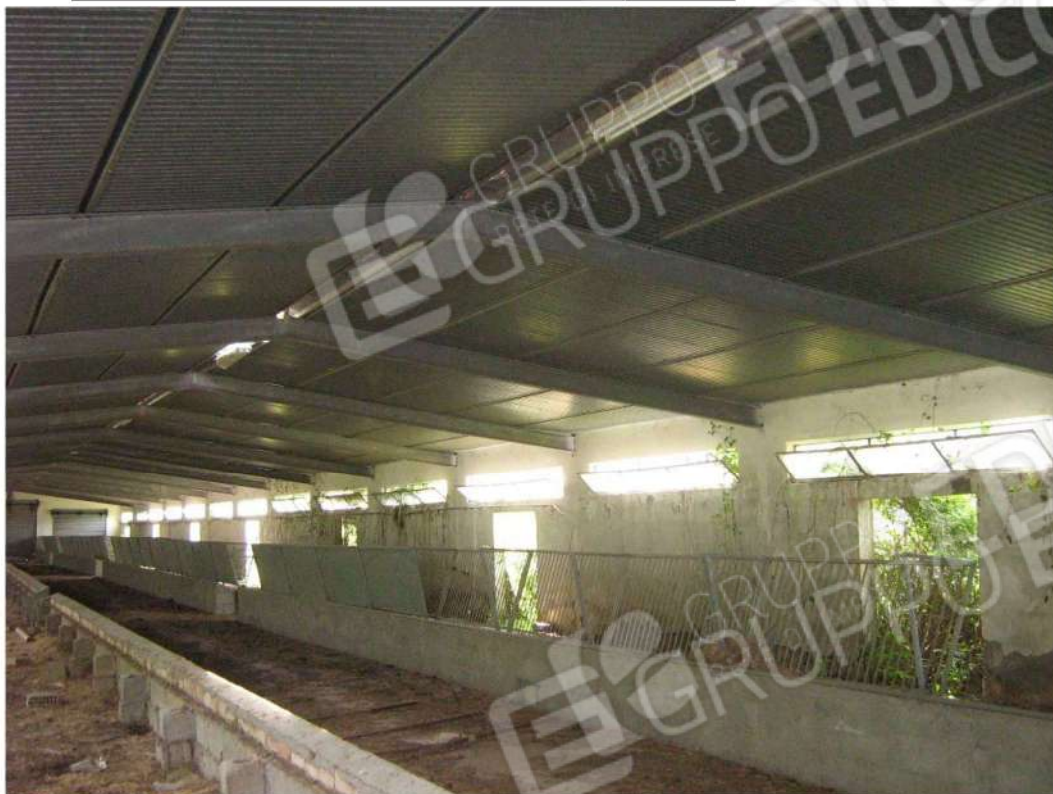
Foto n. 141: ambiente interno del fabbricato "I" (lotto n. 3).
