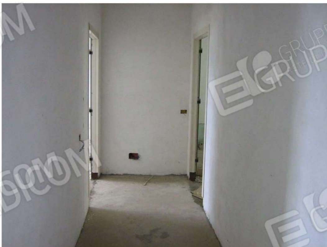
Foto n. 34: particolare corridoio di distribuzione del piano terra – Fabbricato “A” (lotto n. 4).
