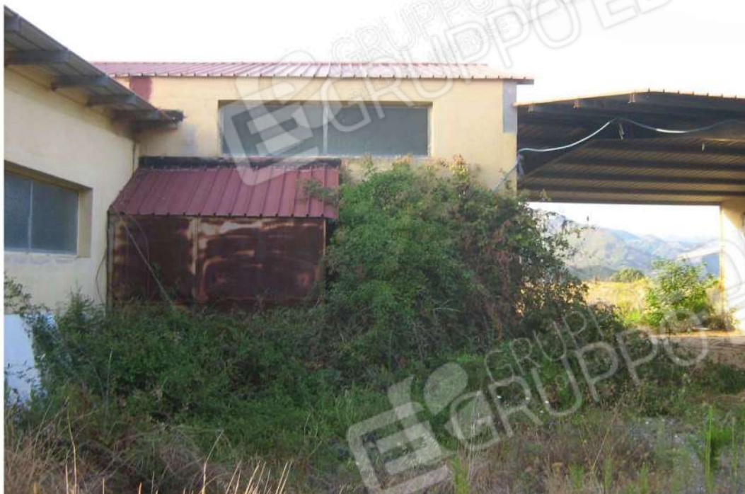
Foto n. 125: prospetto Sud - Fabbricato "H" (lotto n. 3).
