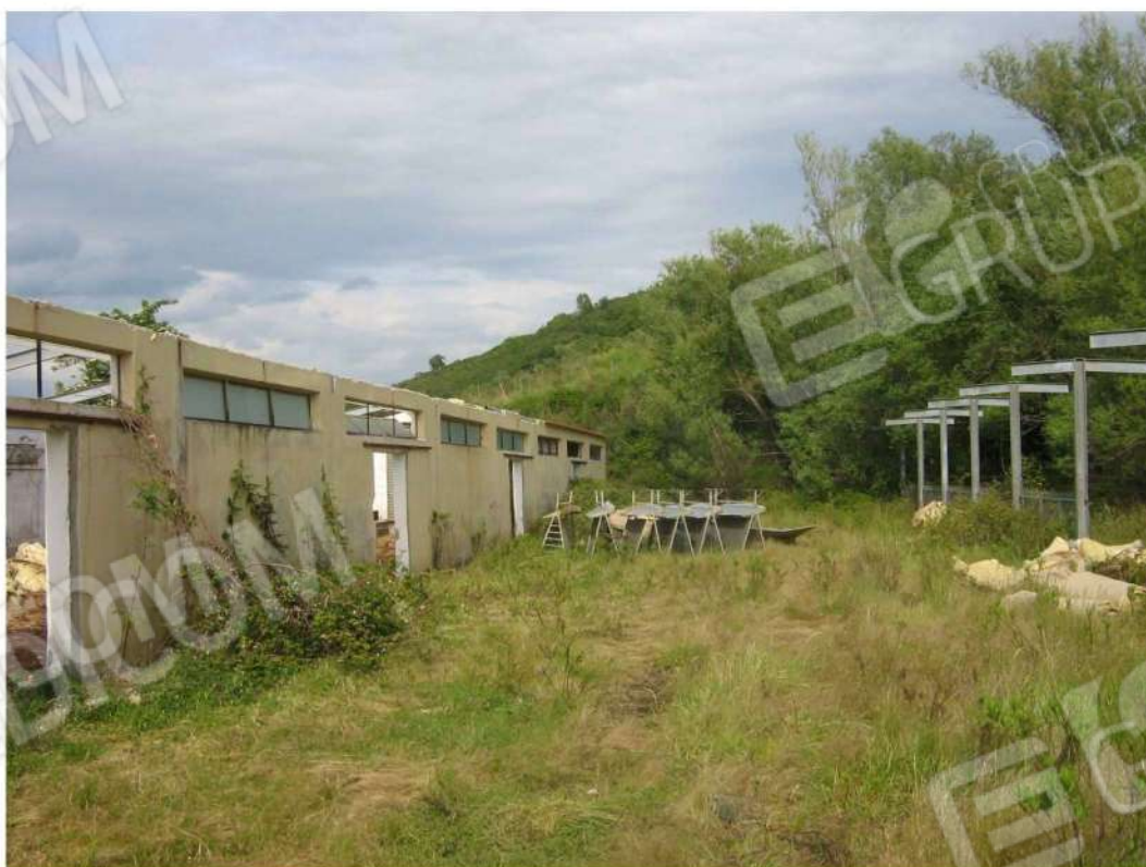
Foto n. 82: prospetto Sud-Sud-Est - Fabbricato “E” (lotto n. 4).
