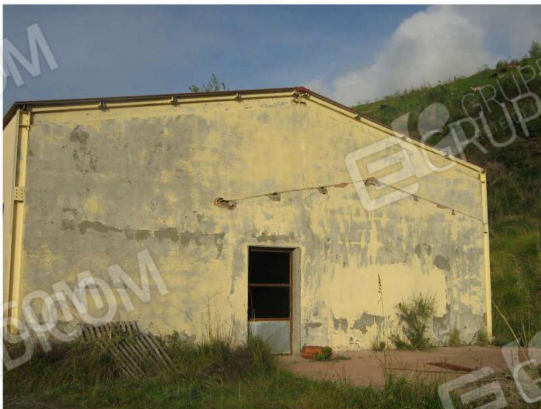
Foto n. 42: prospetto Sud-Ovest - Fabbricato "B" (lotto n. 4).
