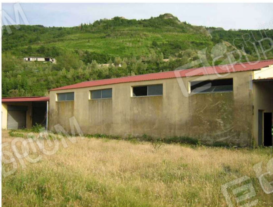
Foto n. 120: foto prospettiva fabbricato “H” (lotto n. 3).
