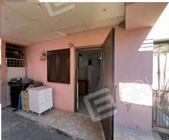
Ingresso cantina Piano Terra
