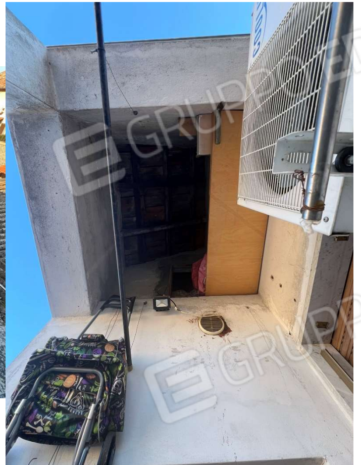
Piccola loggia in soggiorno, in affaccio su altre proprietà
