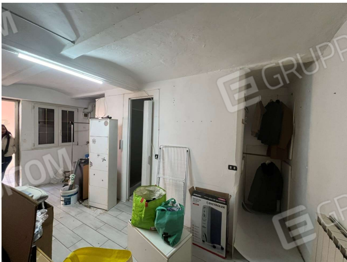
Cantina - Stato dei Luoghi
