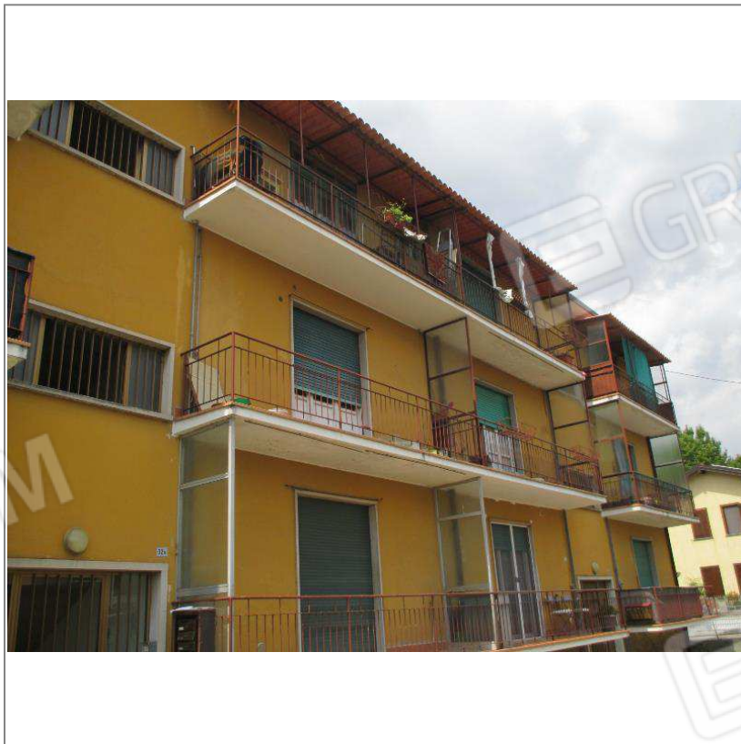
- Complesso condominiale - Fronte est, appartamento al primo piano -
