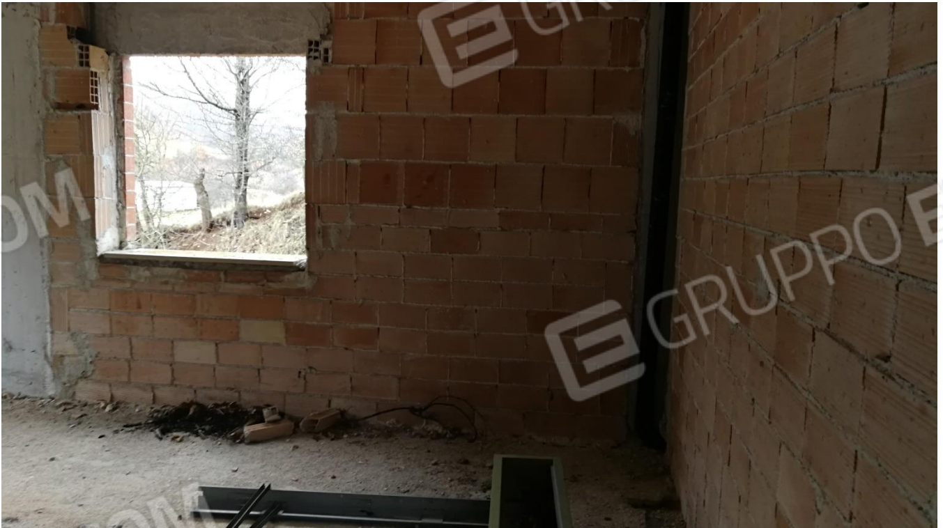
Foto 08 – Vano 01 (Piano Terra)
