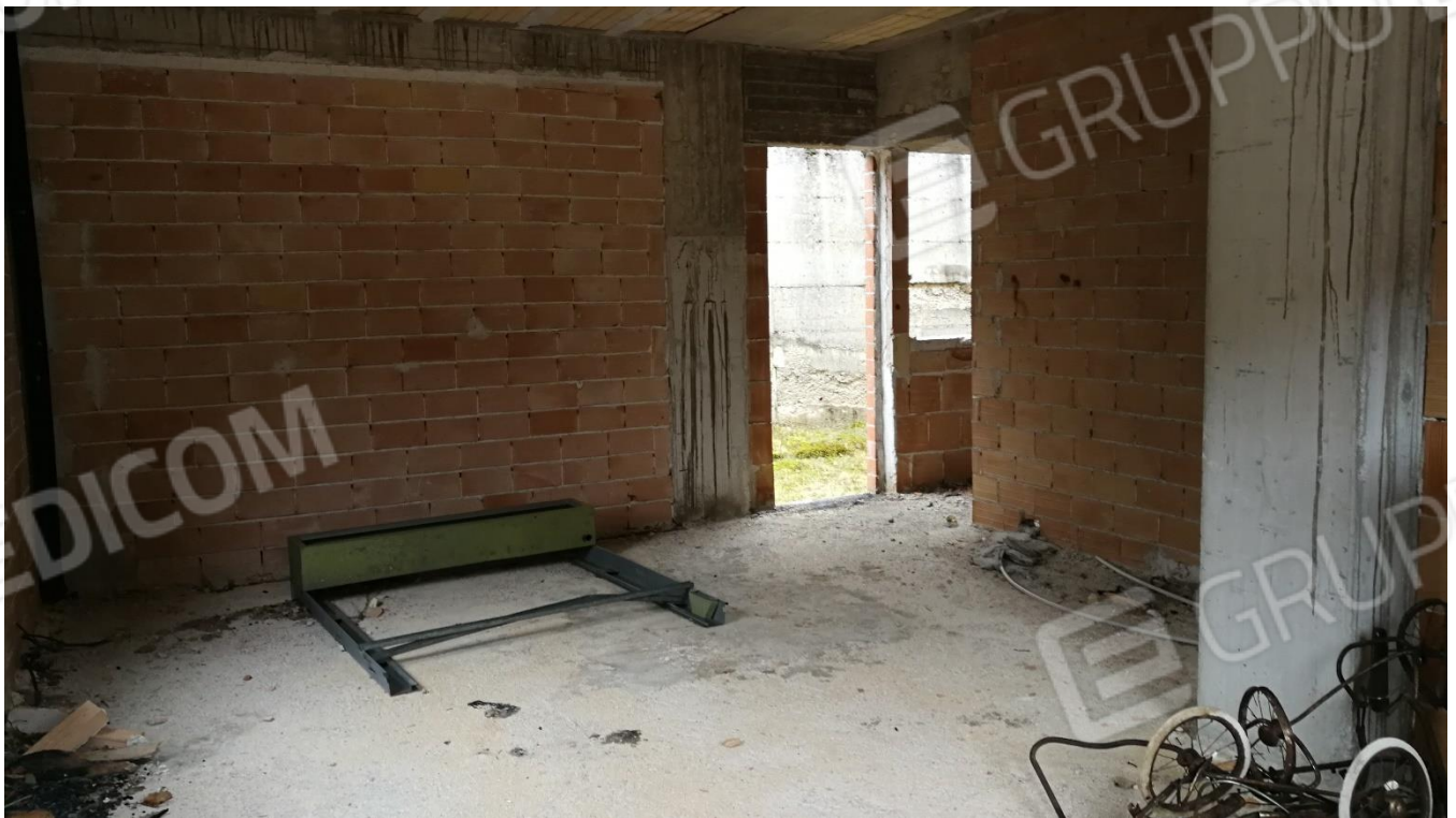
Foto 10 - Vano 01 (Piano Terra)
