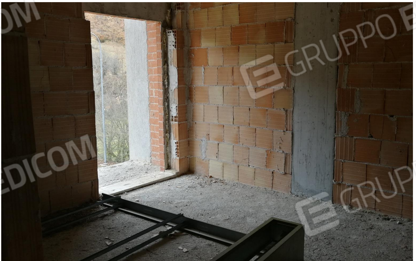
Foto 04 – Vano 05 (Piano Primo)
