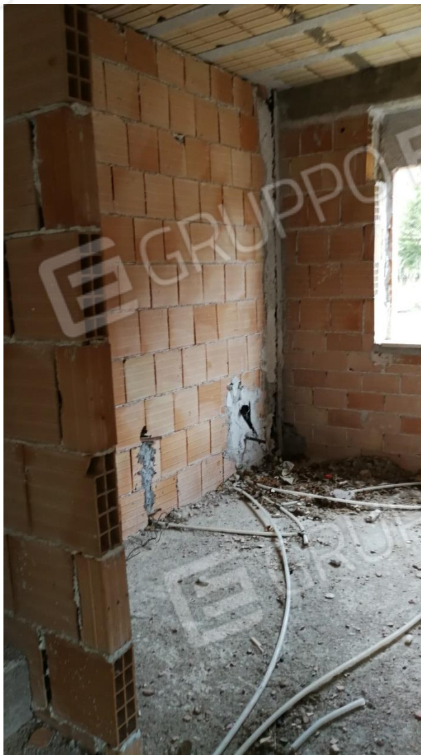
Foto 09 - Vano 02 (Piano Terra)
