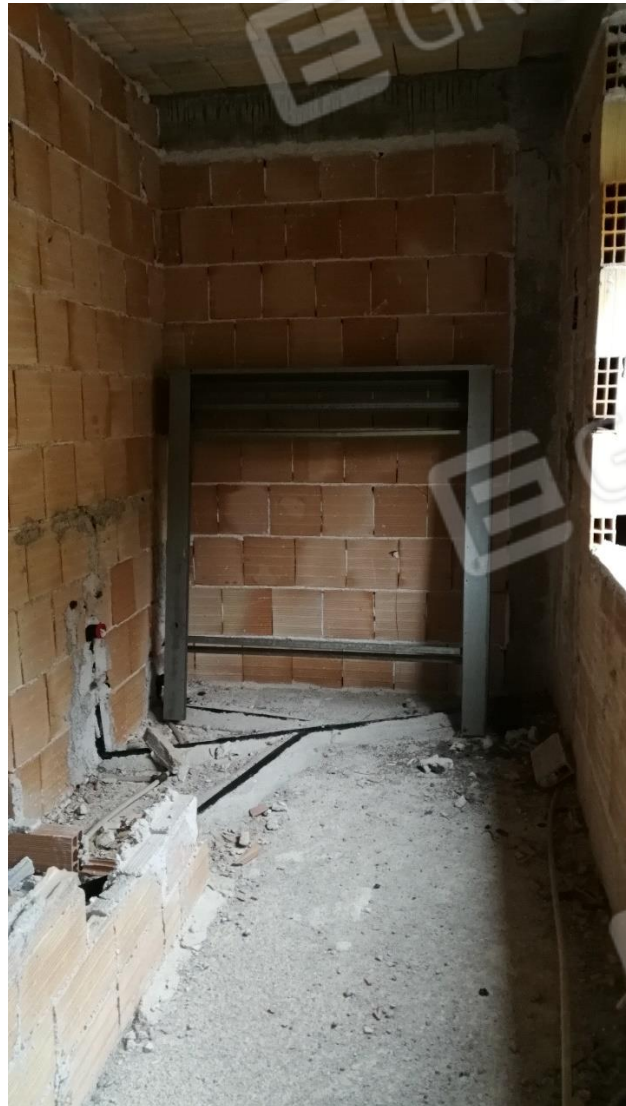
Foto 06 – Vano 04 (Piano Primo)
