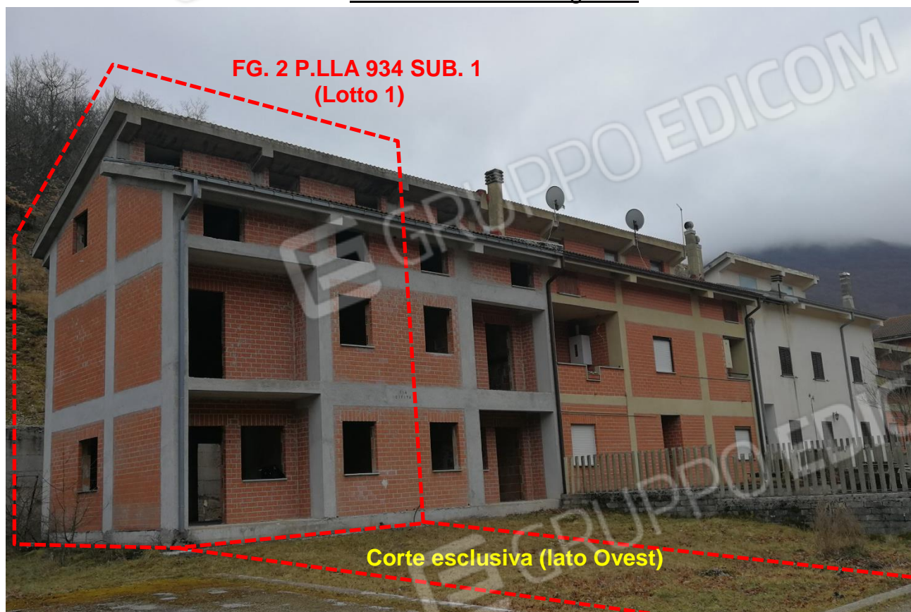
Foto 01 – Vista Esterna lato Ovest (Ingresso)
