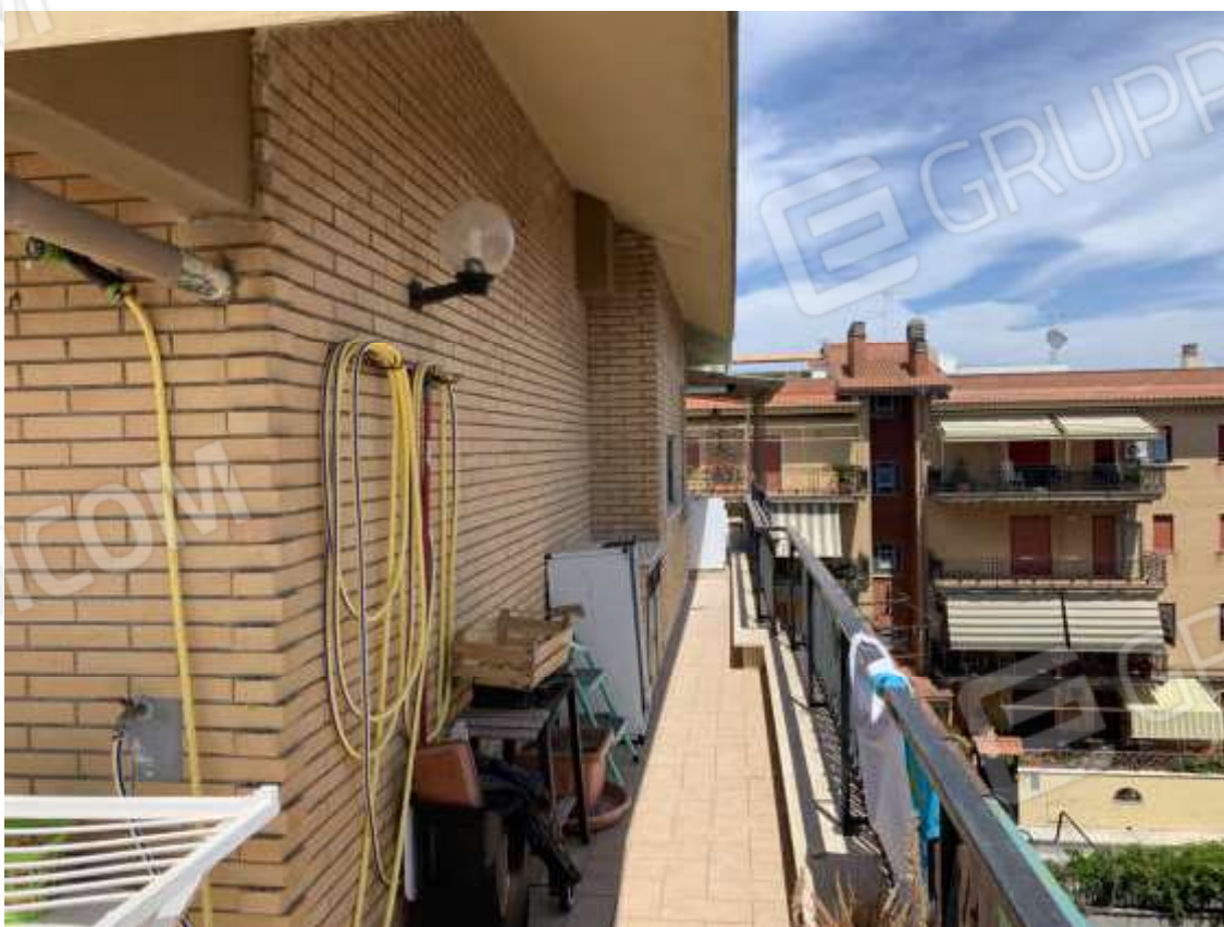
Foto N. 10: Lotto B - Particolare del terrazzo dal lato di sud-est
