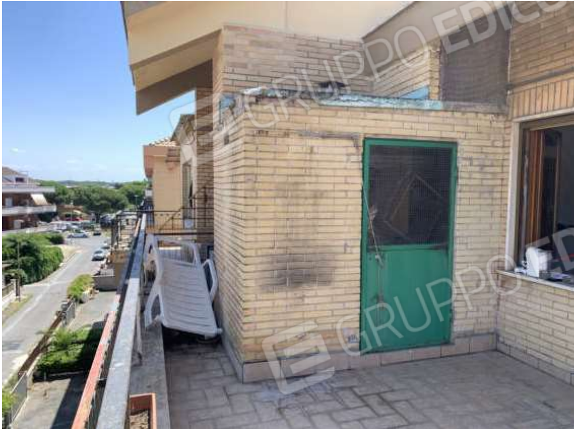
Foto N. 5: Lotto A) - particolare dal terrazzo, lato posteriore, verso il piccolo volume tecnico oggetto di demolizione e stato in pristino
