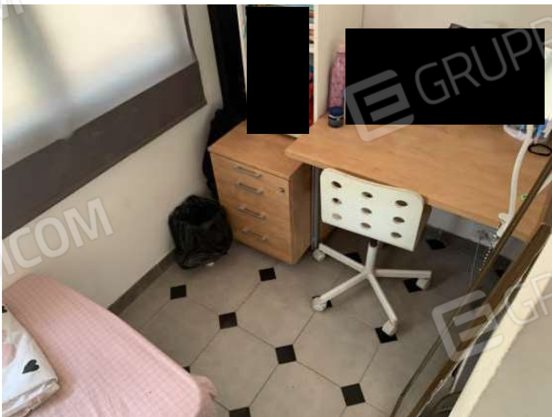
Foto N. 16: Lotto B – Particolare dell'ampliamento oggetto di opere di demolizione e ripristino
