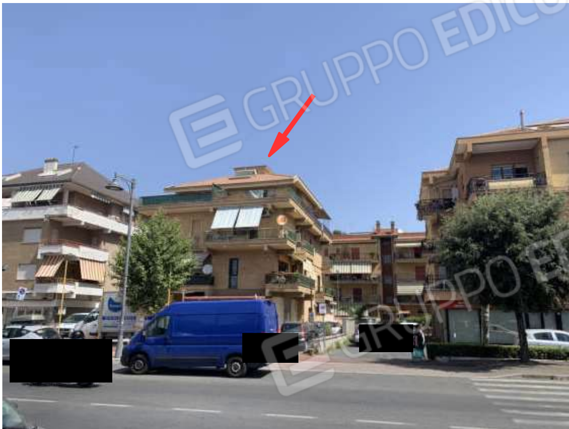
Foto N. 1: Foto verso la palazzina, centrale rispetto alla foto, da Via Palo Laziale. I due appartamenti coinvolgono l'intero piano attico.
