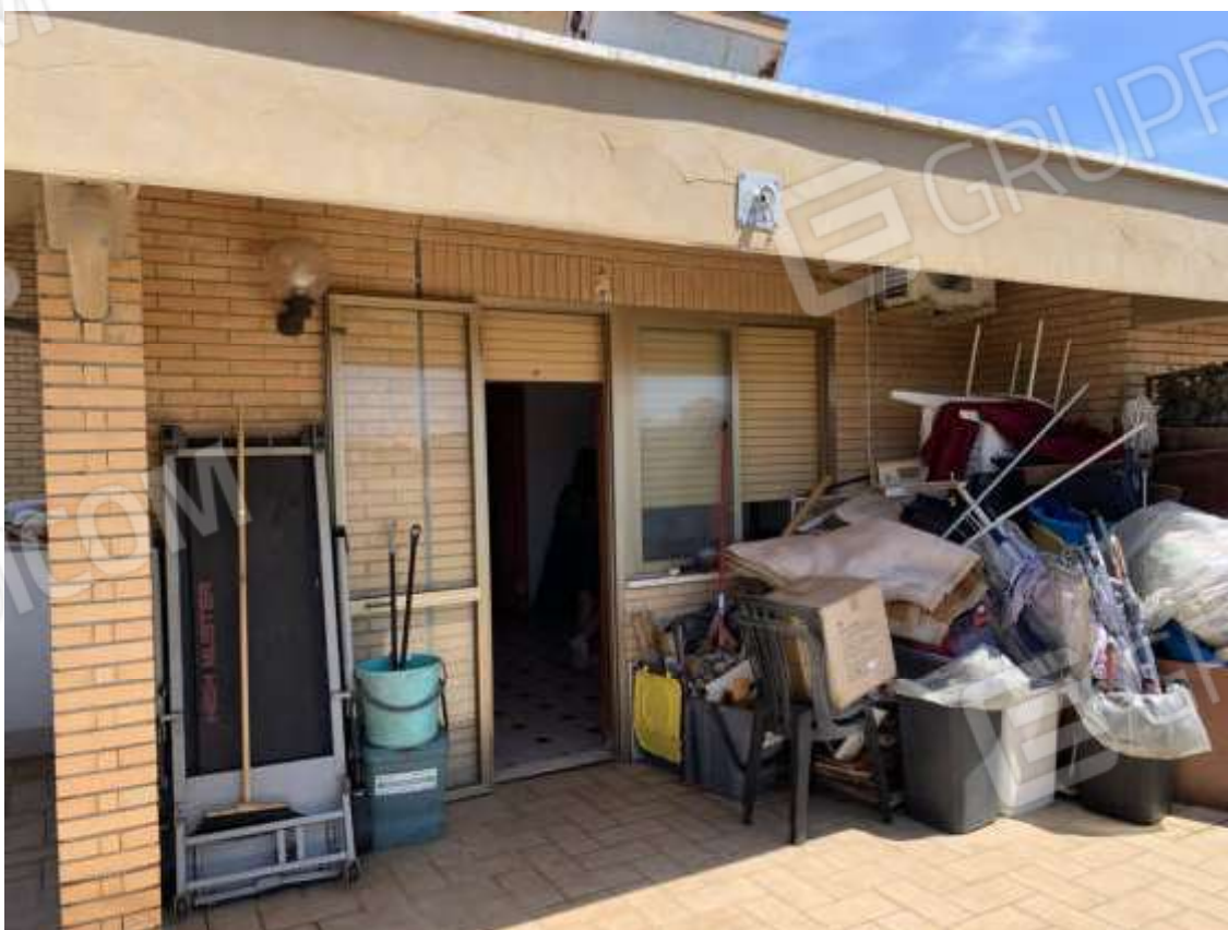
Foto N. 4: Lotto A) - Particolare del terrazzo dal lato che affaccia su Via Palo Laziale
