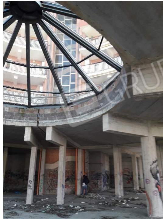
Fig.15 e 16 vista dell'ambiente interno al locale commerciale e del lucernaio
