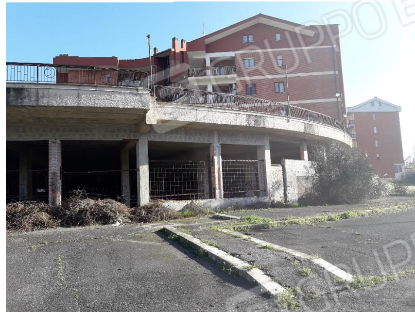
Fig.5 e 6 vista esterna del lato Nord-Ovest del bene pignorato
