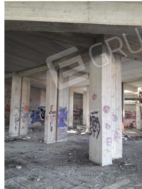
Fig.19, 20 e 21 viste dell'ambiente interno al locale commerciale e delle pareti divisorie con parti condominiali
