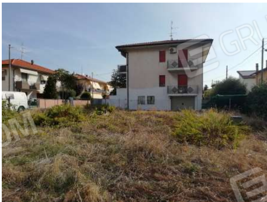
Foto n. 2 – Vista Lato Rimini
