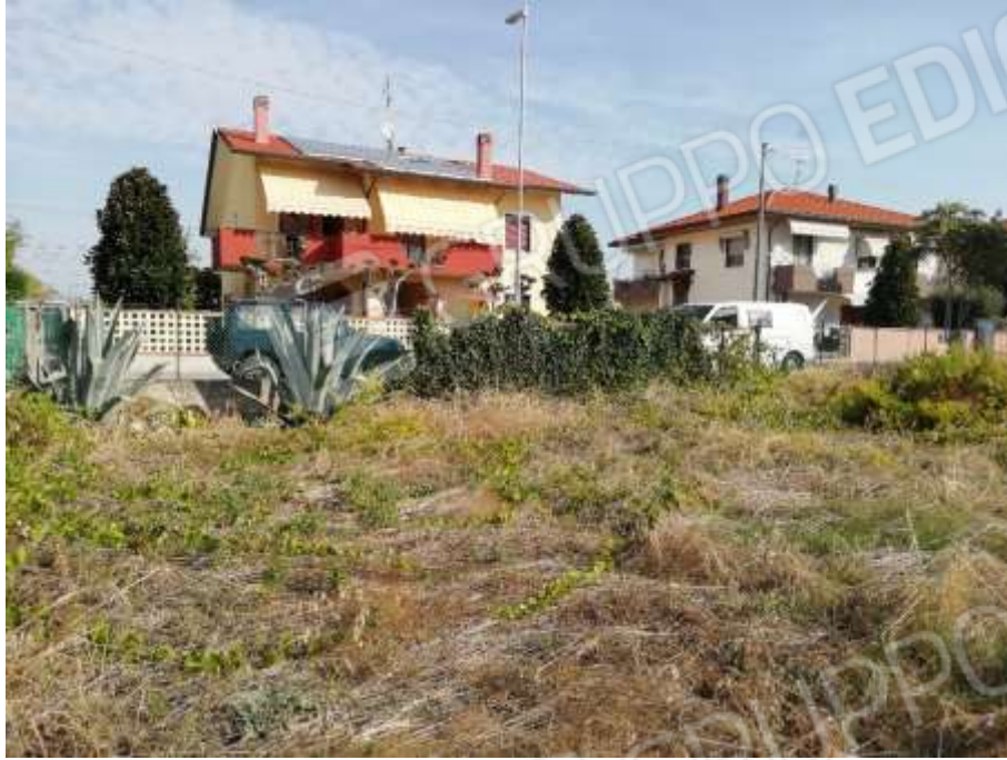
Foto n. 3 – Vista fronte strada Via Caduti in Guerra
