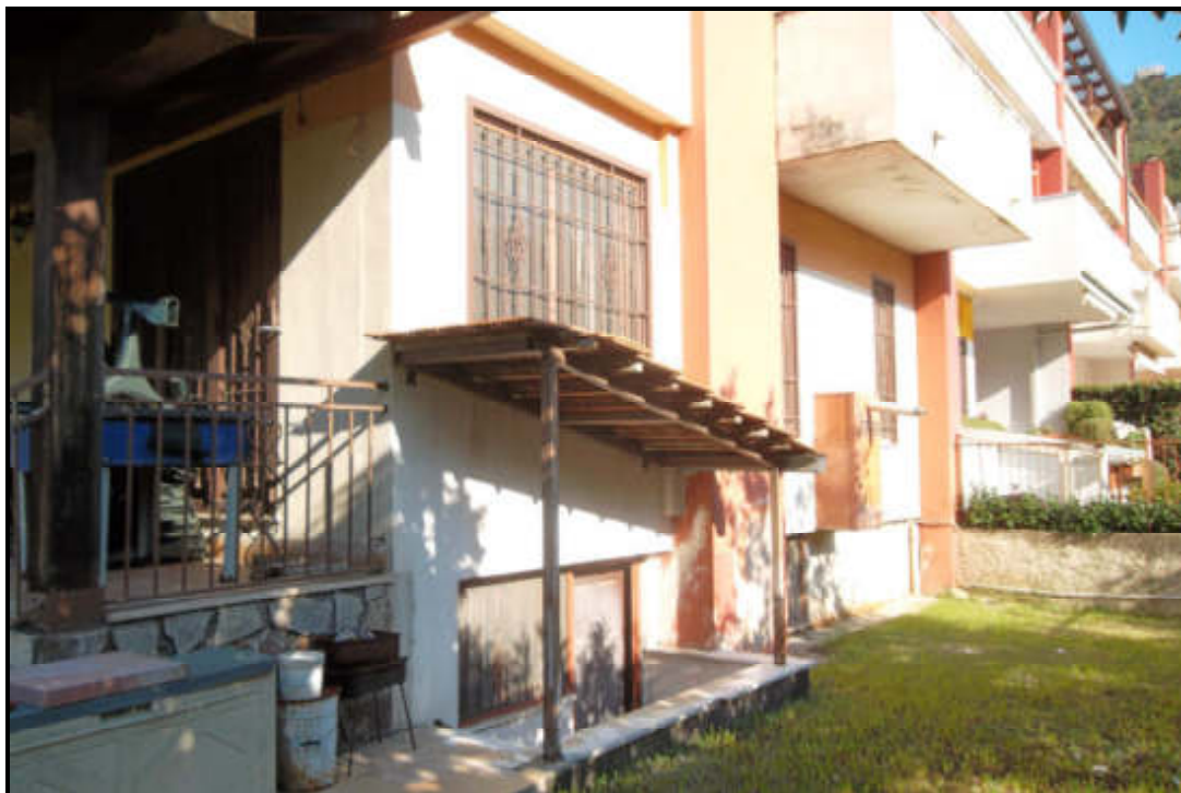
Foto n. 7 – Area esterna privata pertinenziale all'immobile – Giardino uscita dalla tavernetta
