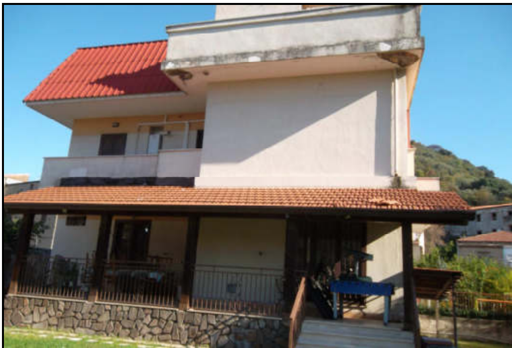
Foto n. 12 – Prospetto lato giardino
