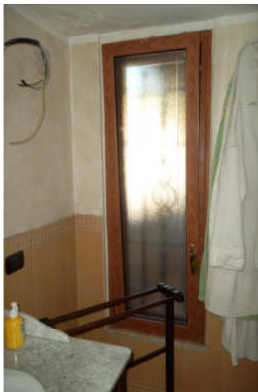
Foto n. 43 – Piano Sottotetto – Bagno
