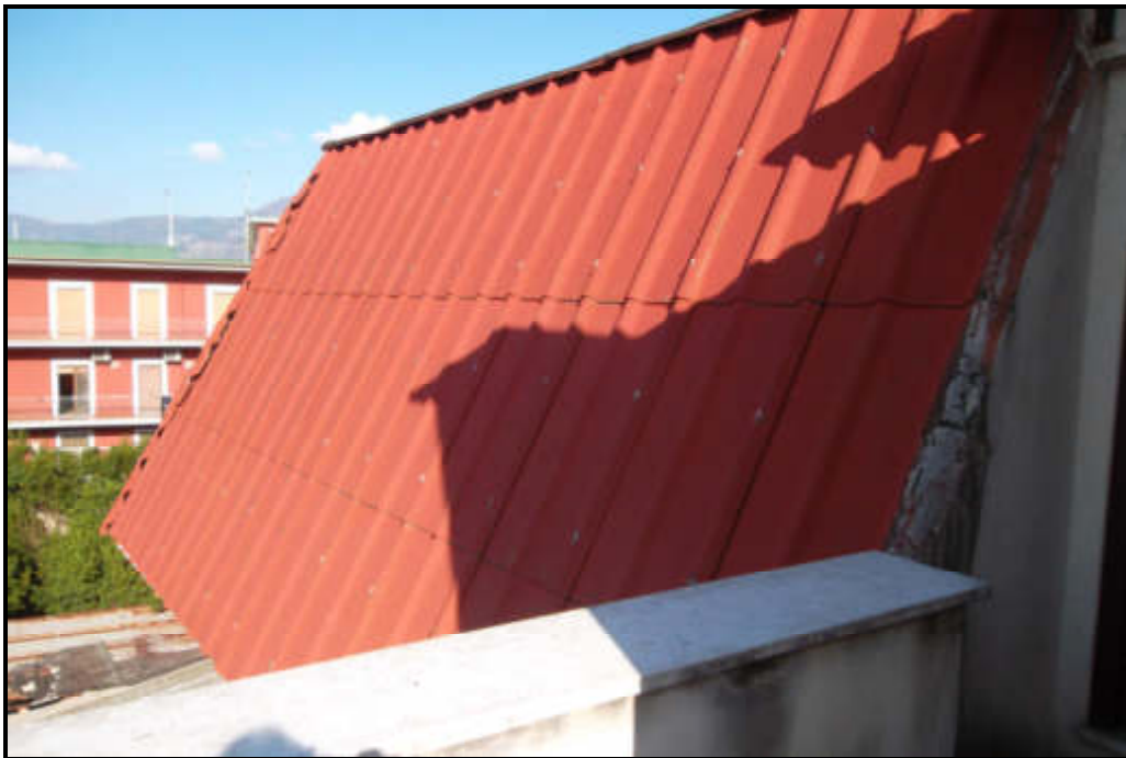
Foto n. 38 – Piano Sottotetto –Copertura
