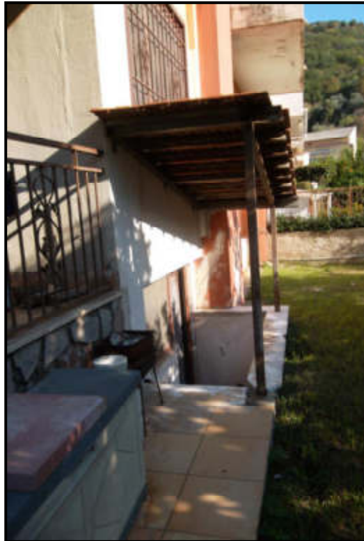
Foto n. 14 – Prospetto lato giardino – uscita tavernetta
