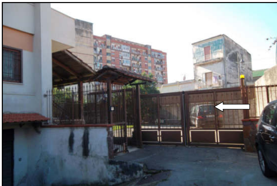
Foto n. 2 – Accesso villetta a schiera ingresso carrabile e pedonale
