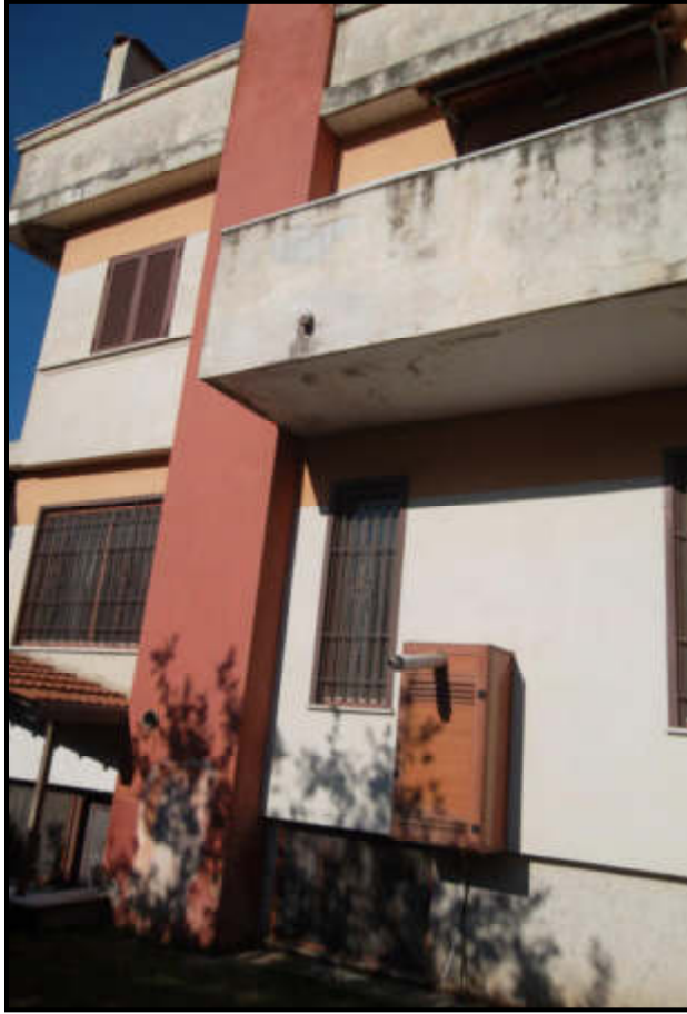
Foto n. 12 – Prospetto lato giardino – uscita tavernetta
