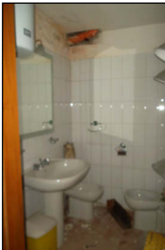
Foto n. 13 – Piano Seminterrato – Bagno
