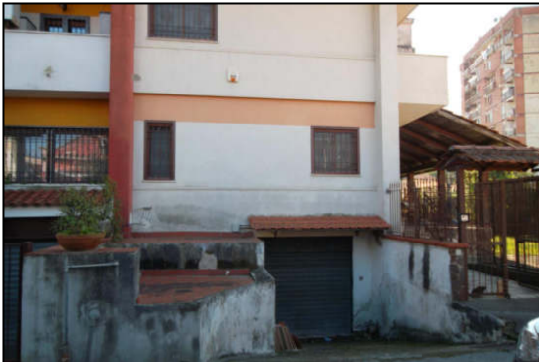
Foto n. 10 – Ingresso Garage seminterrato
