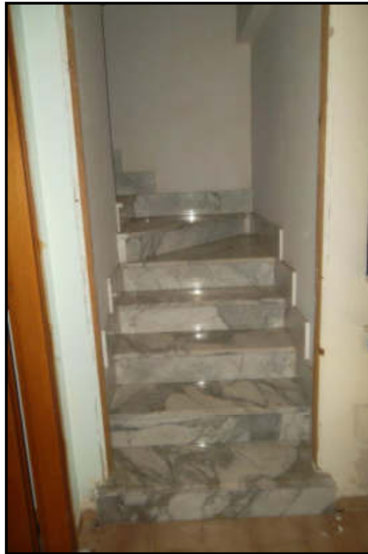
Foto n. 10 – Piano Seminterrato - Scala interna accesso piano seminterrato
