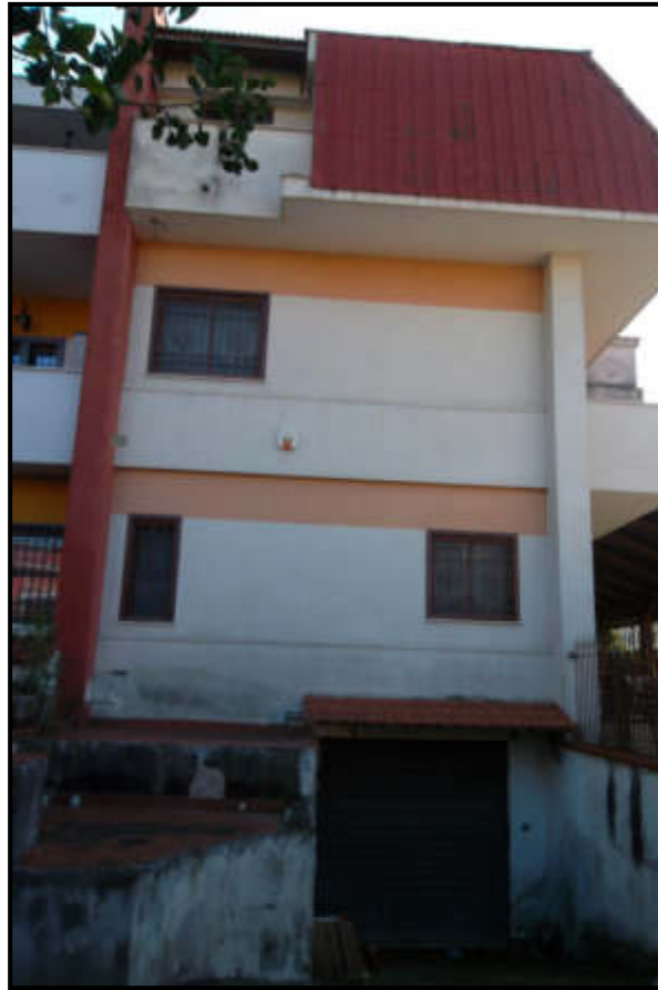
Foto n. 11 – Prospetto lato ingresso
