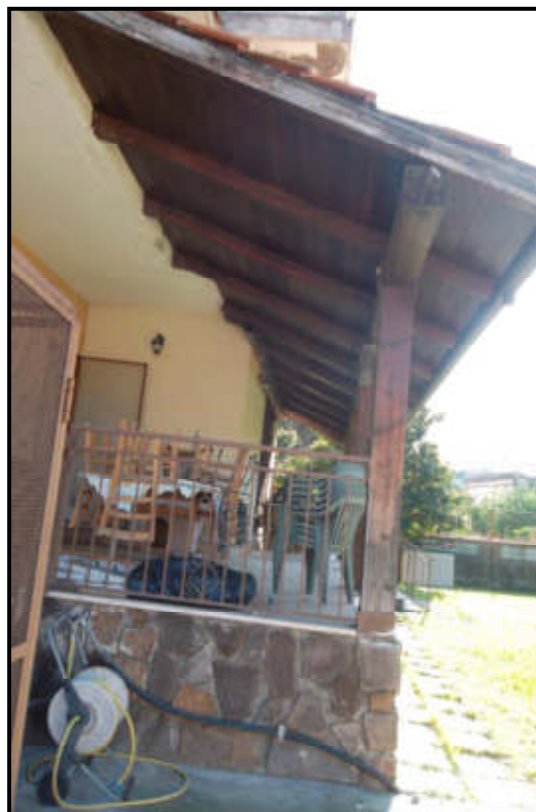
Foto n. 15 – Prospetto lato giardino – Tettoia
