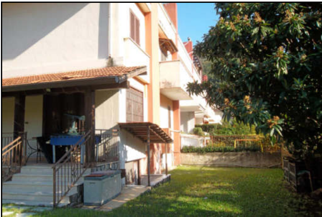
Foto n. 13 - Prospetto lato giardino – uscita tavernetta
