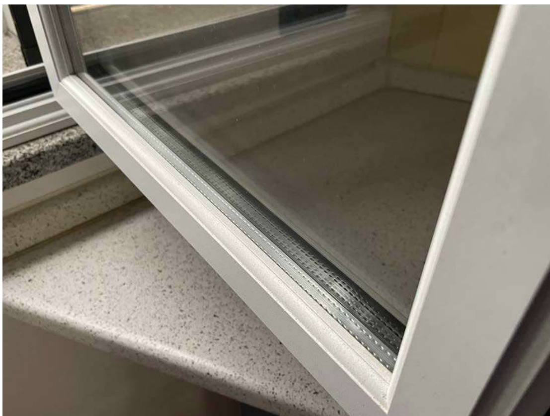
Foto 8 N.C.E.U. Nicotera fg. 28 - p.lla 588 Fabbicato tipo da 1 a 8
