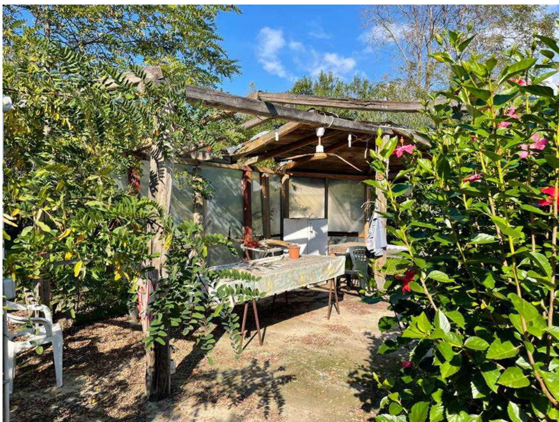
Foto 3 N.C.T. Nicotera fg. 28 - p.lla 555
