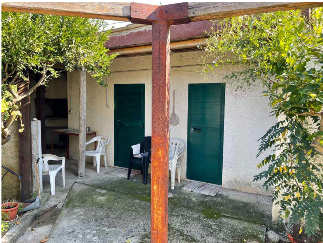
Foto 4 N.C.T. Nicotera fg. 28 - p.lla 555 (fabbricato all'interno del terreno)
