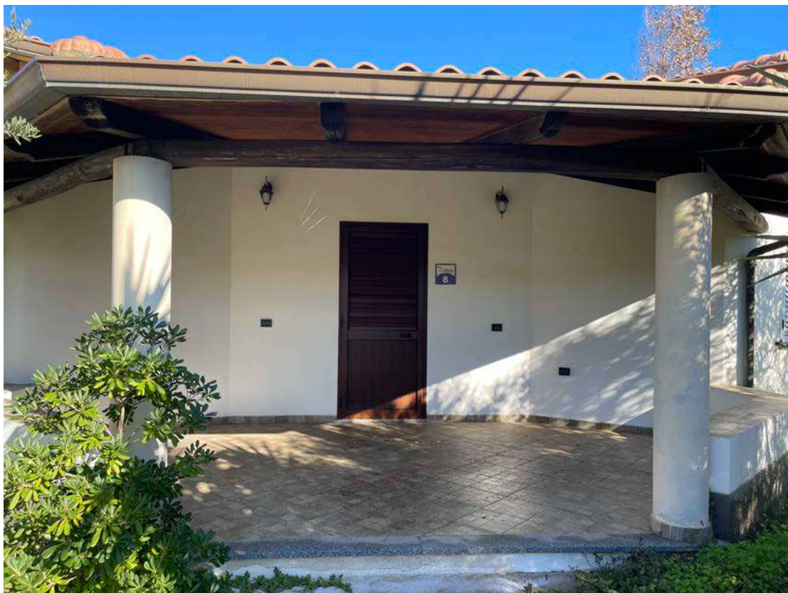
Foto 3 N.C.E.U. Nicotera fg. 28 - p.lla 588 Fabbicato tipo da 1 a 3 e da 6 a 8
