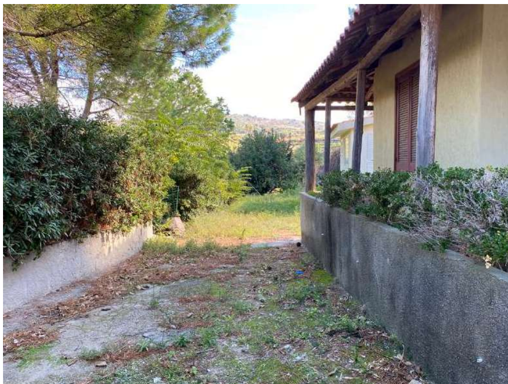
Figura 4 – Situazione di fatto del confine Nord – Nord-Est
