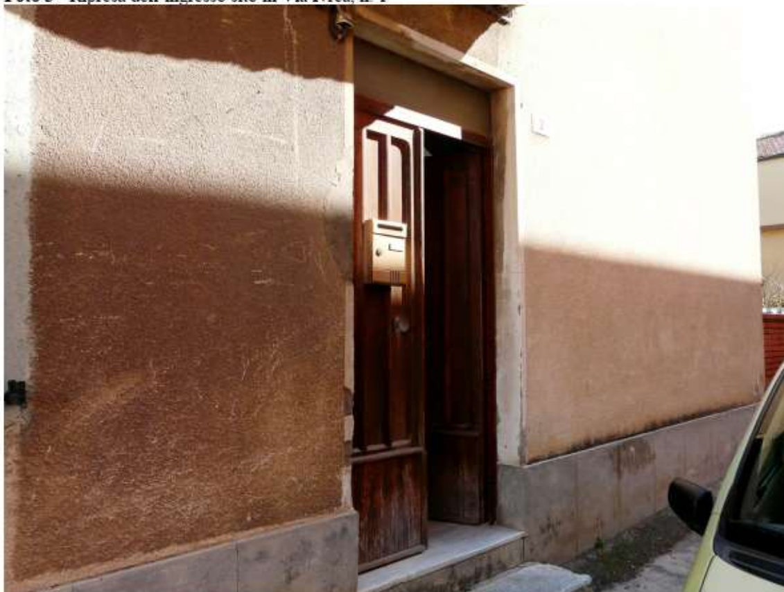
Foto 3 - Ripresa dell'ingresso sito in Via Ivrea, n. 1
