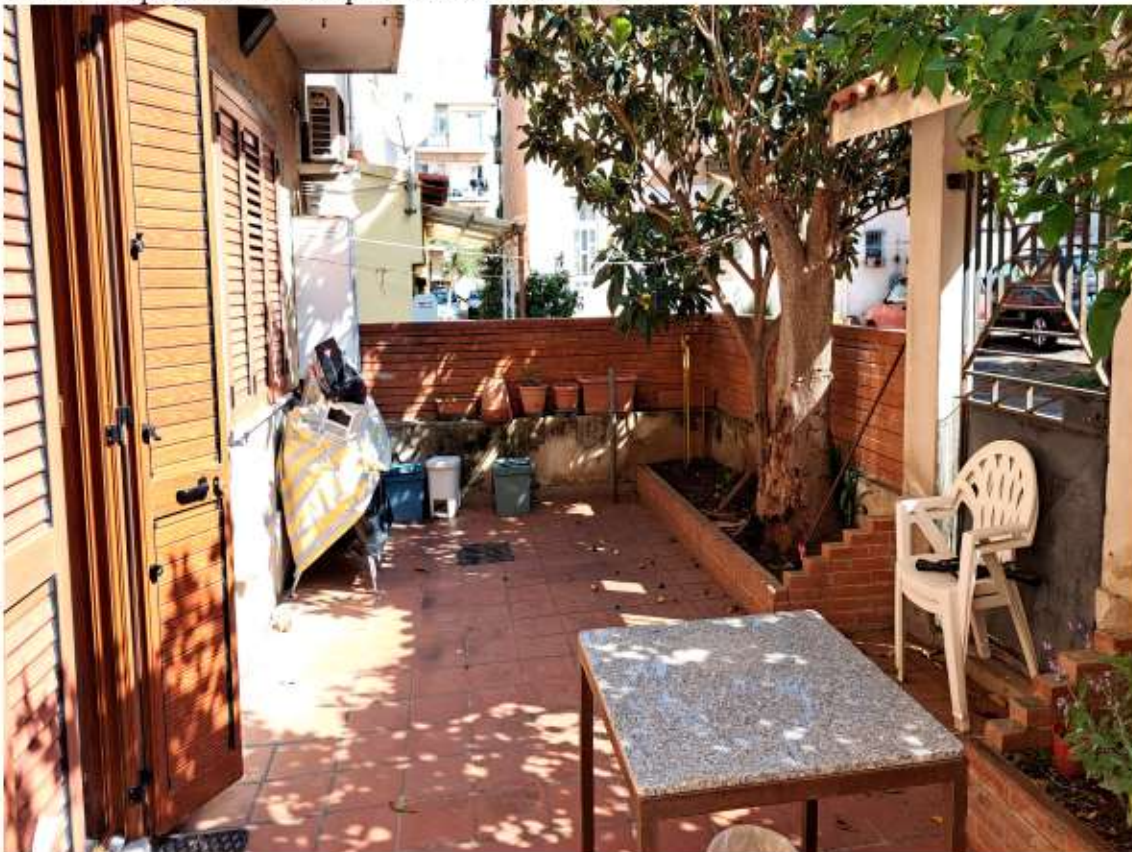
Foto 12 – Ripresa del cortiletto posto sul retro del fabbricato
