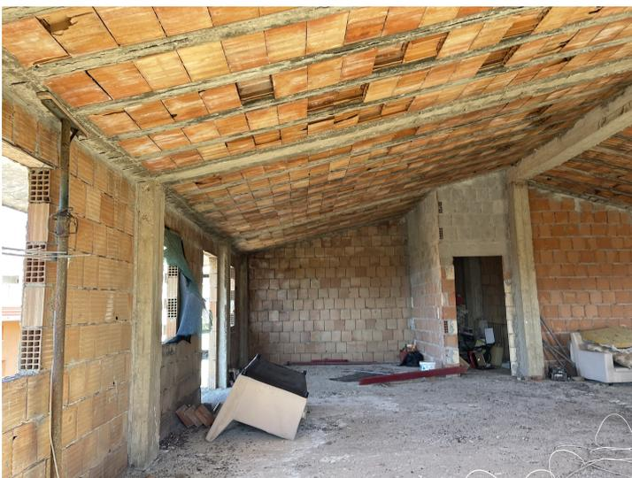
Il magazzino, come il locale confinante, non è dotato di alcun tipo di finitura sia sul pavimento che sui muri.
