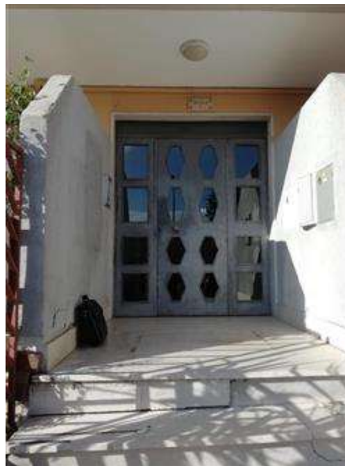
PORTONE DI INGRESSO AL FABBRICATO
