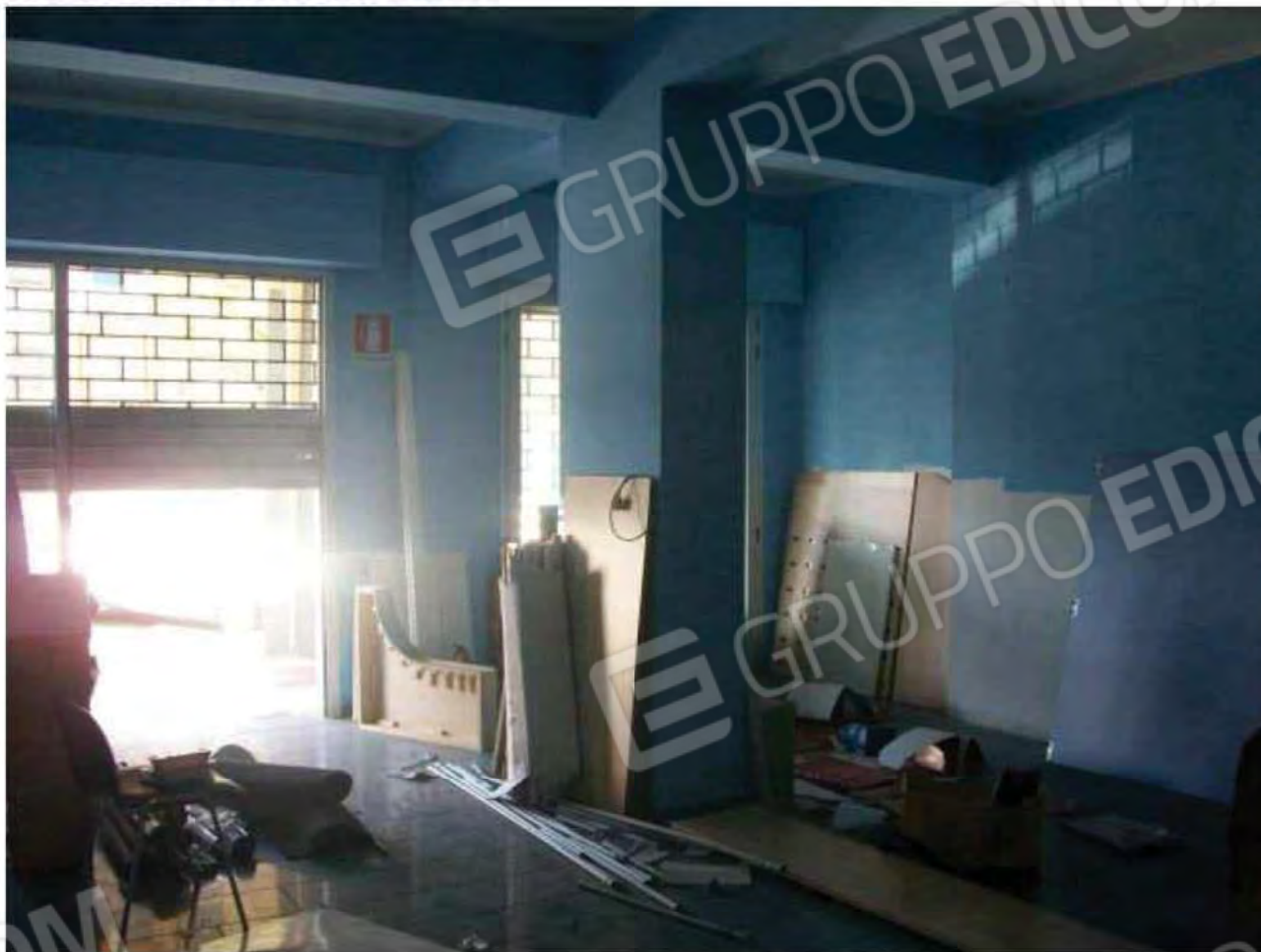
Interno locale commerciale Sub. 98
