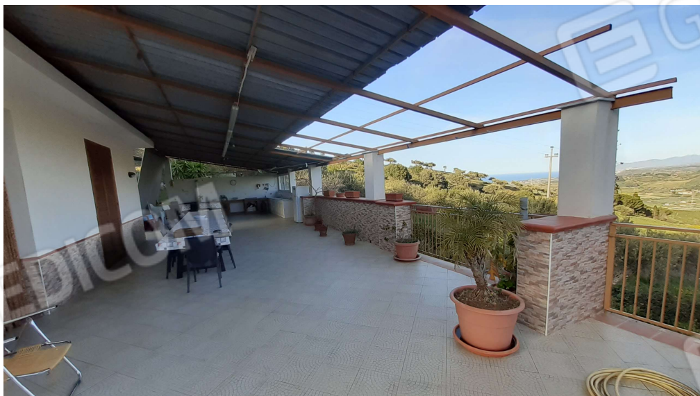
Tettoia metallica e pilastri in muratura da demolire
