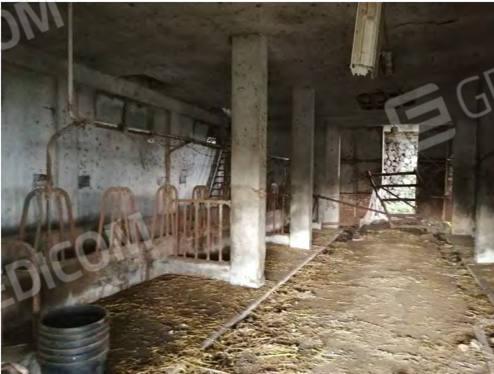
FO-32 CORPO DI FABBRICA PART. 486 – A – PIANO TERRA
