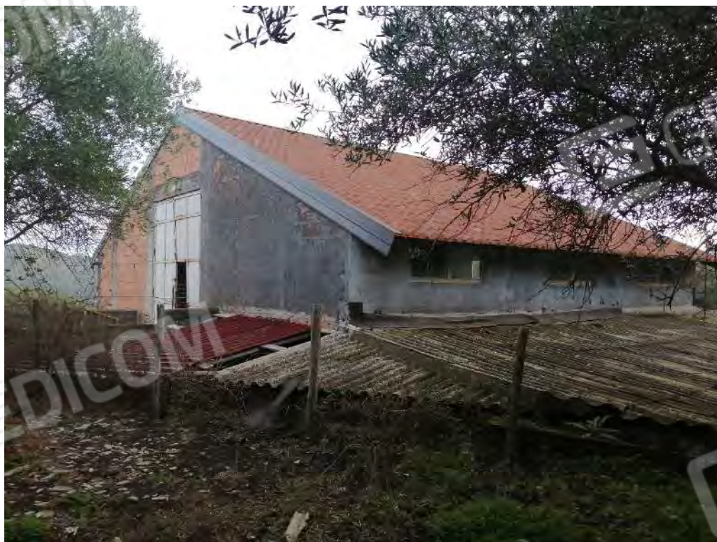
FO-28 CORPO DI FABBRICA PART. 486 - A
