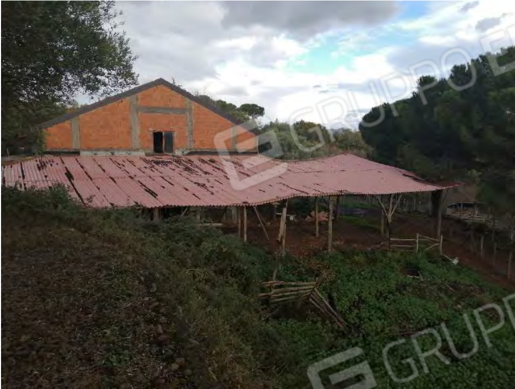
FO-29 CORPO DI FABBRICA PART. 486 – A – SPECIFICA TETTOIA
