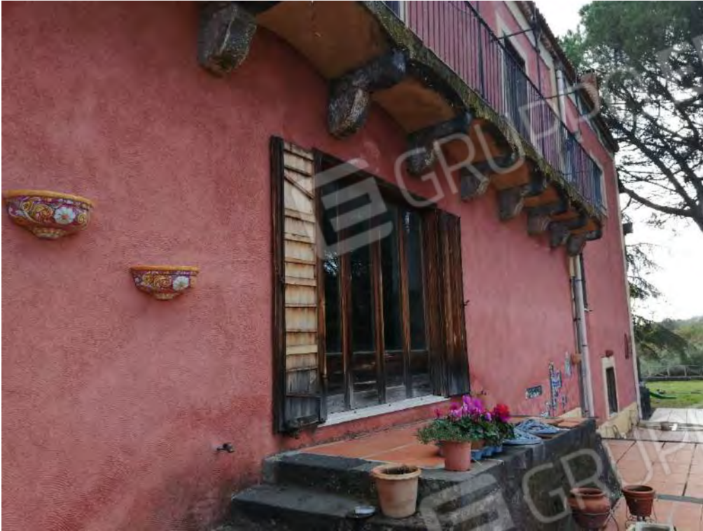
FO-69 PART. 159 FOGLIO 31 RIF. C – ESTERNO LATO OVEST – INGRESSO AL PALMENTO
