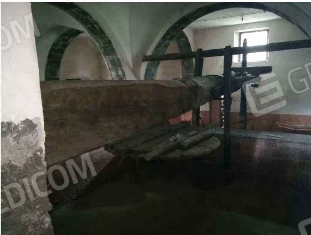
FO-80 PART. 159 FOGLIO 31 RIF. C – INTERNO PALMENTO -PIANO PRIMO
