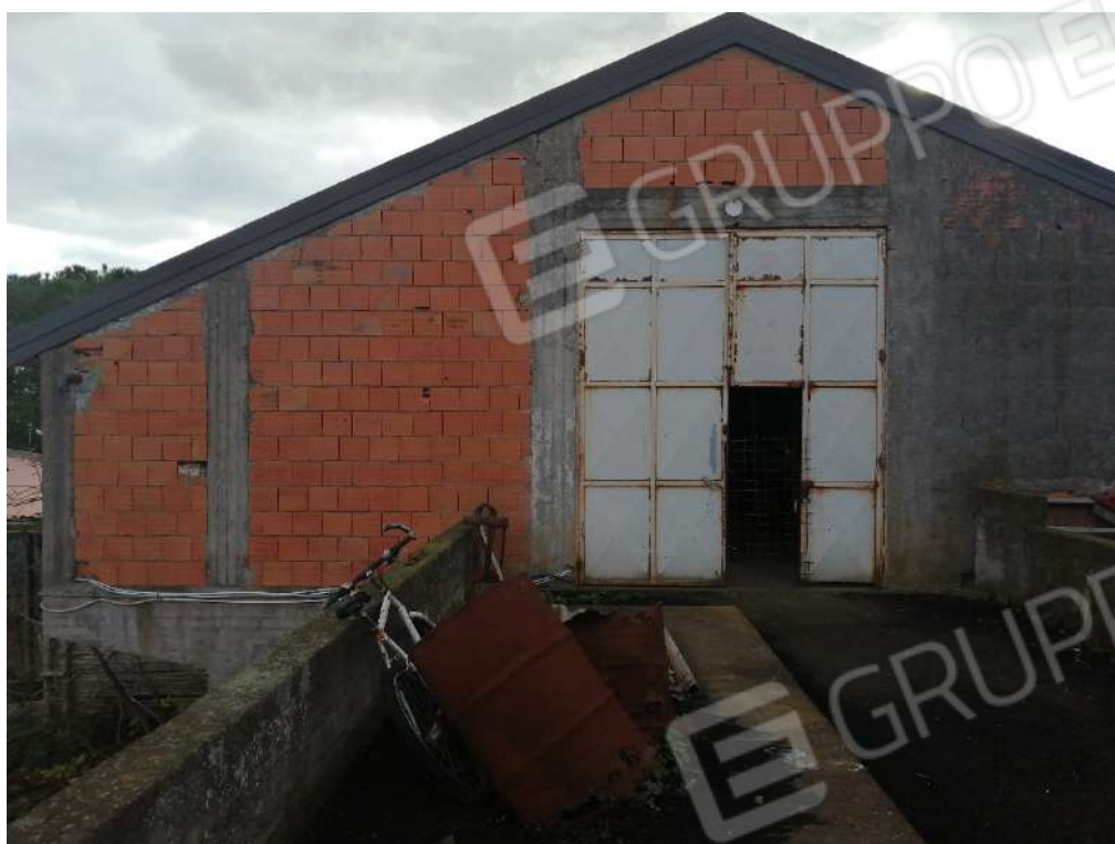
FO-27 CORPO DI FABBRICA PART. 486 - A
