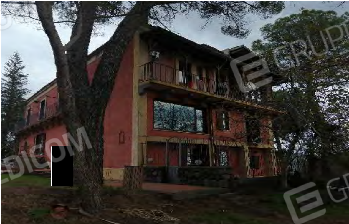
FO-68 PART. 159 FOGLIO 31 RIF. C – ESTERNO LATO SUD/OVEST
