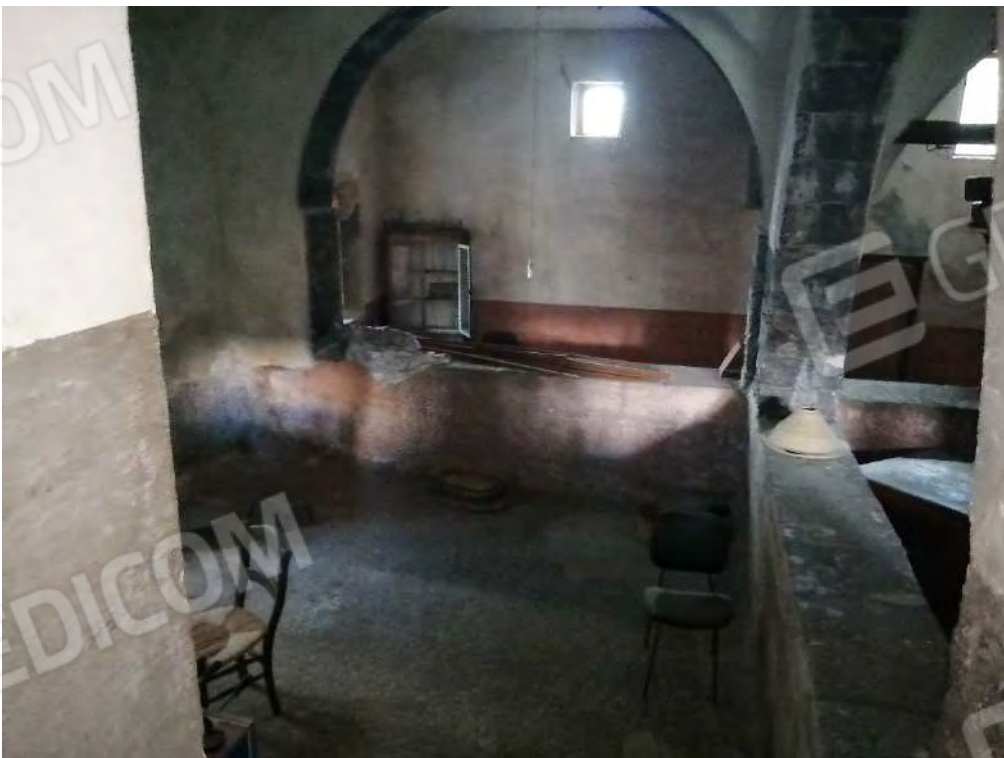
FO-76 PART. 159 FOGLIO 31 RIF. C – INTERNO PALMENTO -PIANO PRIMO
