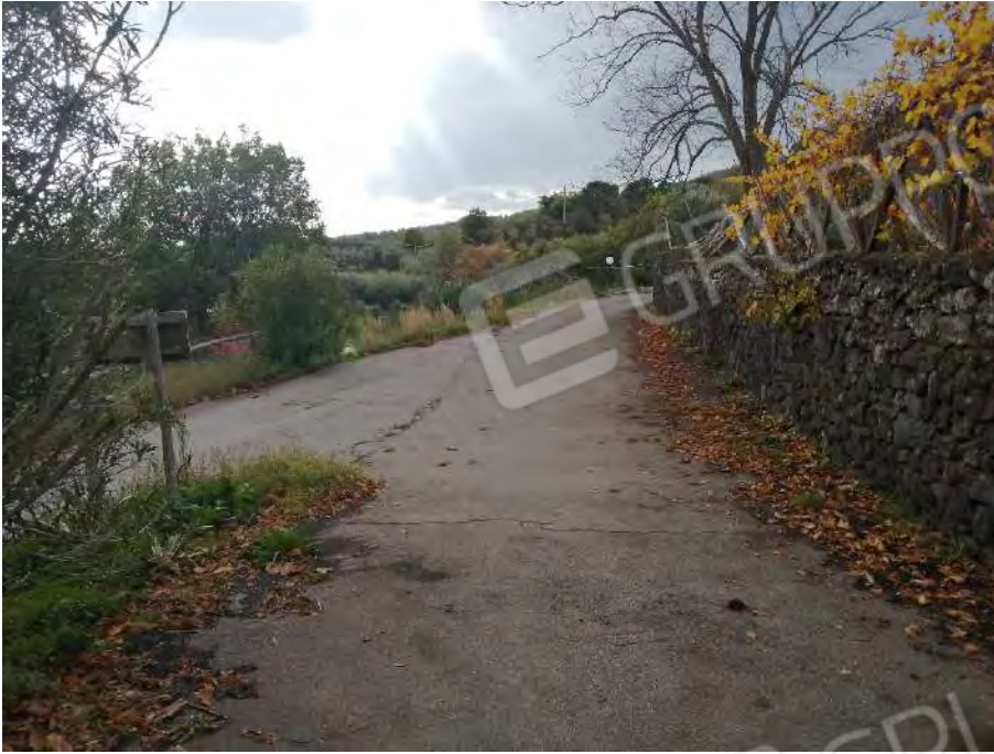
FO-7 STRADE INTERNE DI ACCESSO, TRANSITO E MANOVRA DALL'INGRESSO PRINCIPALE CHE PERÒ RICADONO SU TERRENO NON OGGETTO DELLA PRESENTE PROCEDURA ESECUTIVA.
