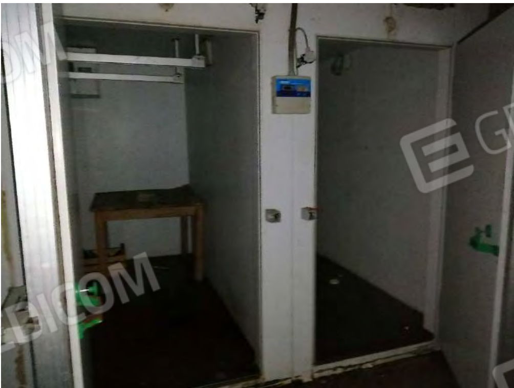
FO-62 PART. 159 FOGLIO 31 RIF. B – INTERNO – CELLE FRIGORIFERE
