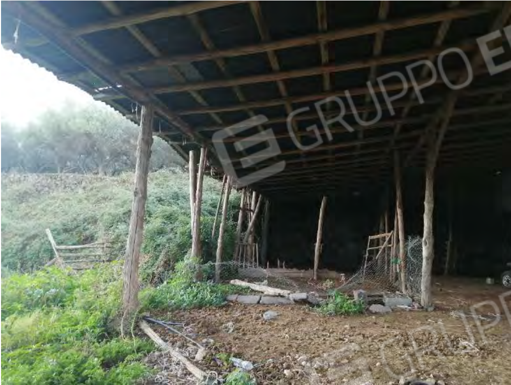
FO-37 CORPO DI FABBRICA PART. 486 – A – SPECIFICA TETTOIA
