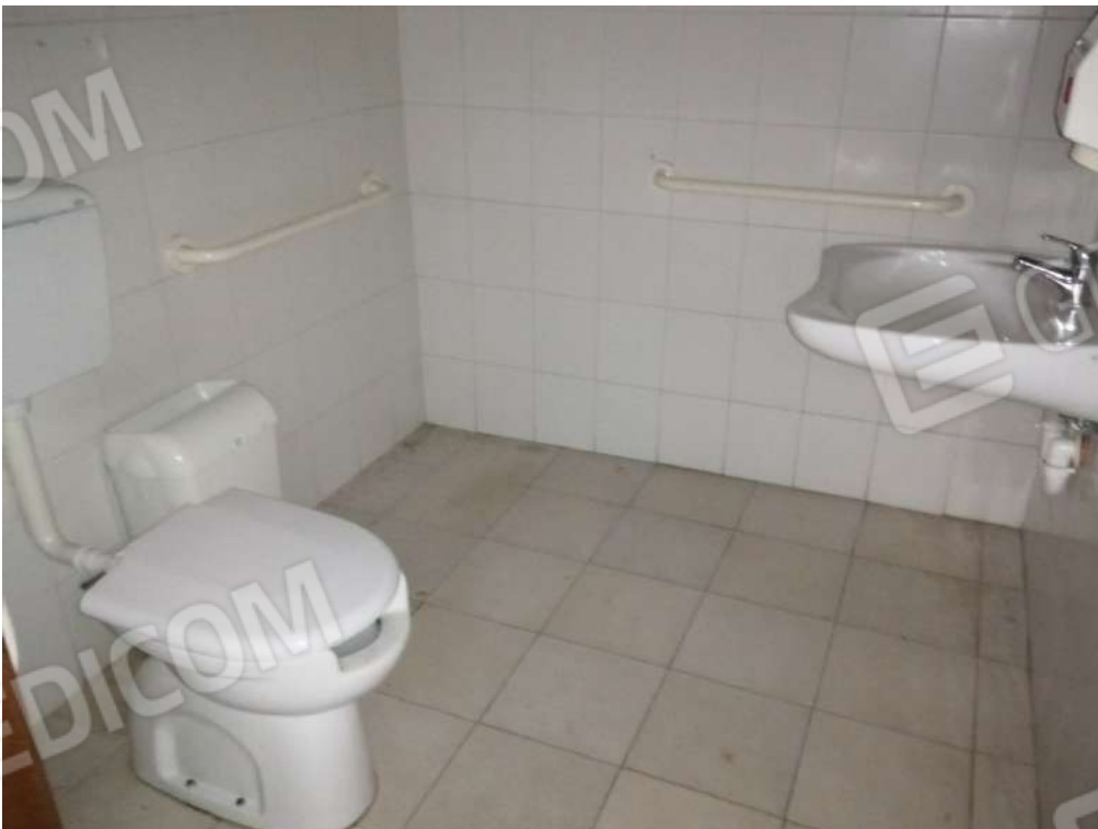
FO-98 PART. 159 FOGLIO 31 RIF. C – INTERNO – PIANO SECONDO LOCALI WC A SERVIZIO DELLA ATTIVITA' DI RISTORAZIONE
