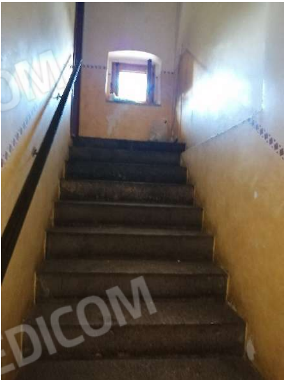
FO-82 PART. 159 FOGLIO 31 RIF. C – INTERNO – SCALA DI ACCESSO AL PIANO SUPERIORE
