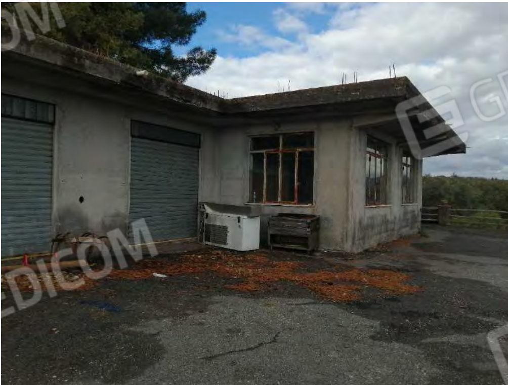
FO-48 PART. 159 FOGLIO 31 RIF. B – ESTERNO
