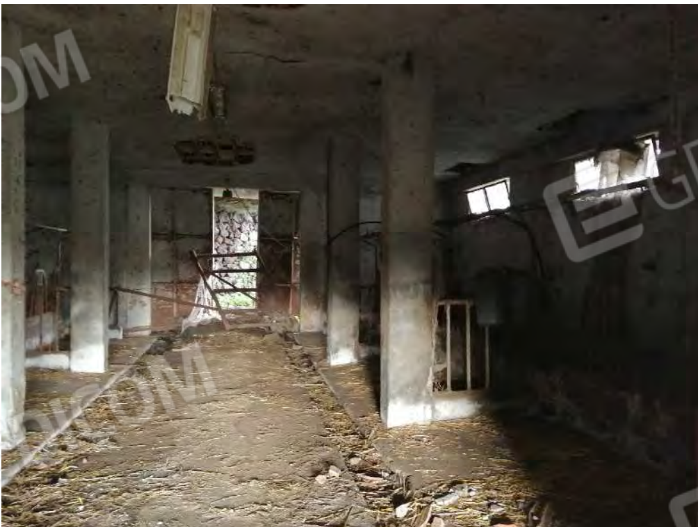
FO-34 CORPO DI FABBRICA PART. 486 – A – PIANO TERRA
