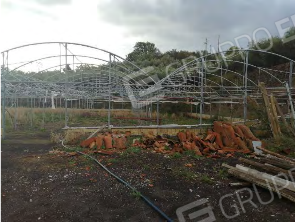
FO-43 STRUTTURE EX SERRE PRESENTI SU PORZIONE PARTICELLA 485 FOGLIO 34
