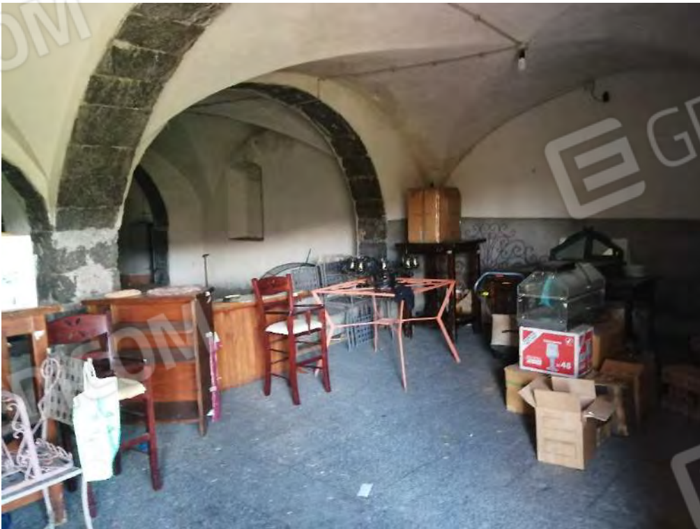
FO-78 PART. 159 FOGLIO 31 RIF. C – INTERNO PALMENTO -PIANO PRIMO
