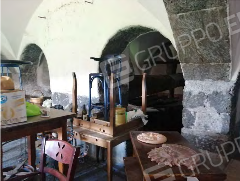
FO-77 PART. 159 FOGLIO 31 RIF. C – INTERNO PALMENTO -PIANO PRIMO
