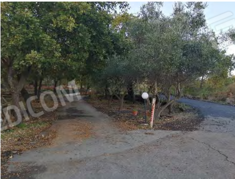
FO-6 STRADE INTERNE DI ACCESSO, TRANSITO E MANOVRA DALL'INGRESSO PRINCIPALE CHE PERÒ RICADONO SU TERRENO NON OGGETTO DELLA PRESENTE PROCEDURA ESECUTIVA.
