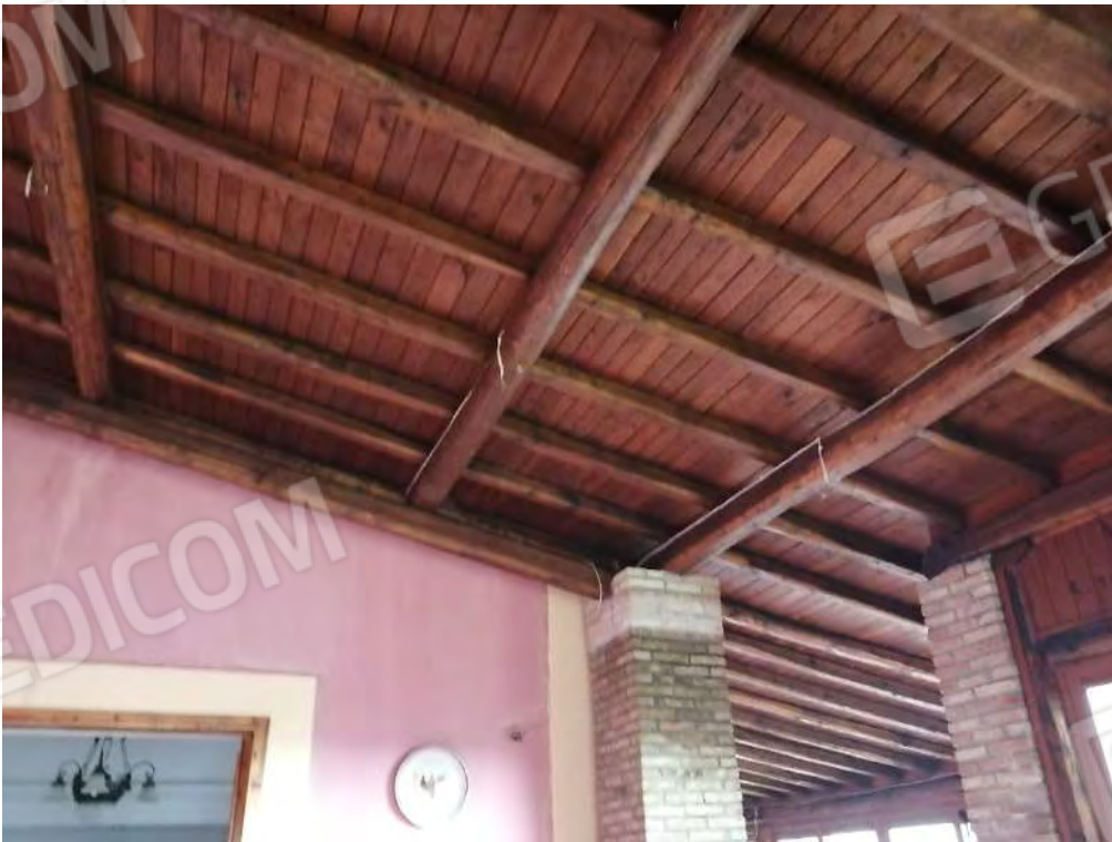
FO-90 PART. 159 FOGLIO 31 RIF. C – INTERNO – PIANO SECONDO - SALA RISTORAZIONE TERRAZZA
