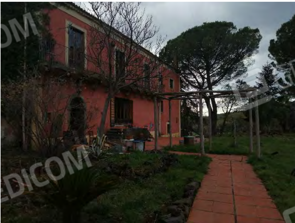
FO-66 PART. 159 FOGLIO 31 RIF. C – ESTERNO LATO NORD/OVEST
