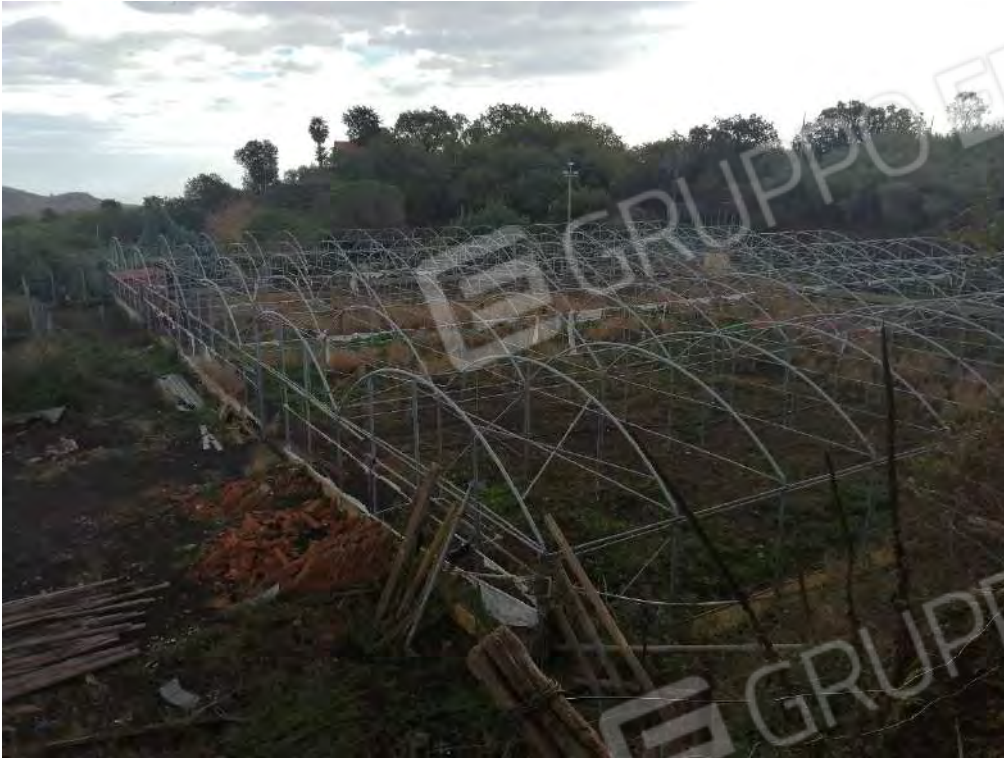
FO-45 STRUTTURE EX SERRE PRESENTI SU PORZIONE PARTICELLA 485 FOGLIO 34
