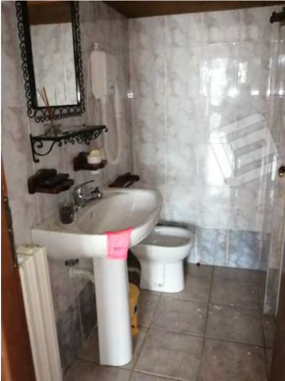
FO-97 PART. 159 FOGLIO 31 RIF. C – INTERNO – PIANO SECONDO LOCALI WC A SERVIZIO DELLA ATTIVITA' DI RISTORAZIONE
