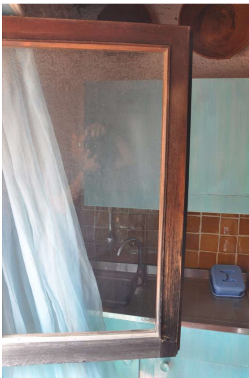
Particolare di uno degli infissi esterni
