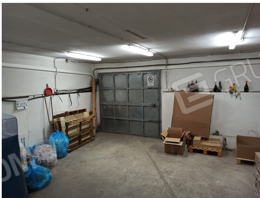
Foto 14_ Vista parcheggio interno piano seminterrato
