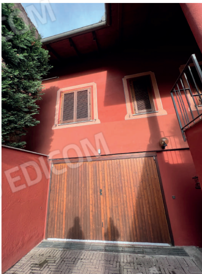
6_Accesso al garage seminterrato
